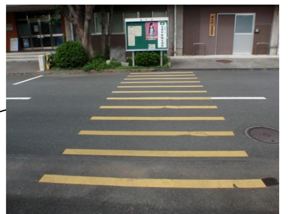
横断歩道の設置により、歩行者の誘導・安全通路を確保することができました。
