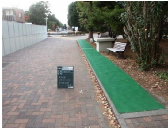
片側一方通行部分には緑地帯に敷きマットを敷き歩行者の動線を明確にし、安全通路を確保しました。
