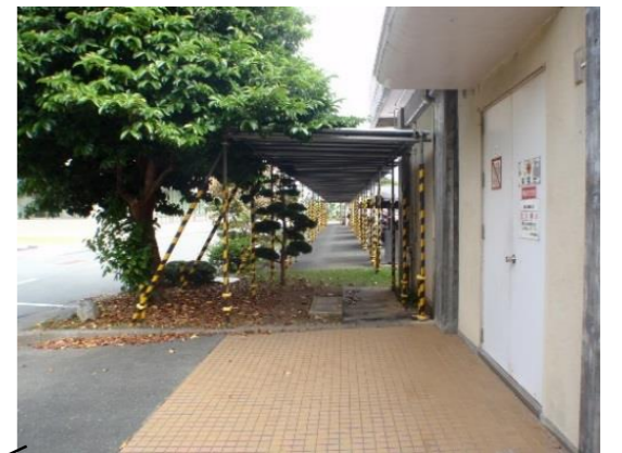
アーケードを設置し、悪天候でも歩行者の安全通路を確保、現場から離れる誘導をしました。
