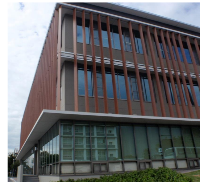
大型ルーバー完成写真
