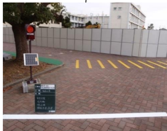
仮囲い設置に伴い構内通路減少の為、信号機を使用し、片側交互通行として車輛の誘導を行いました。また、環境にも配慮し、ソーラー信号機としました。
