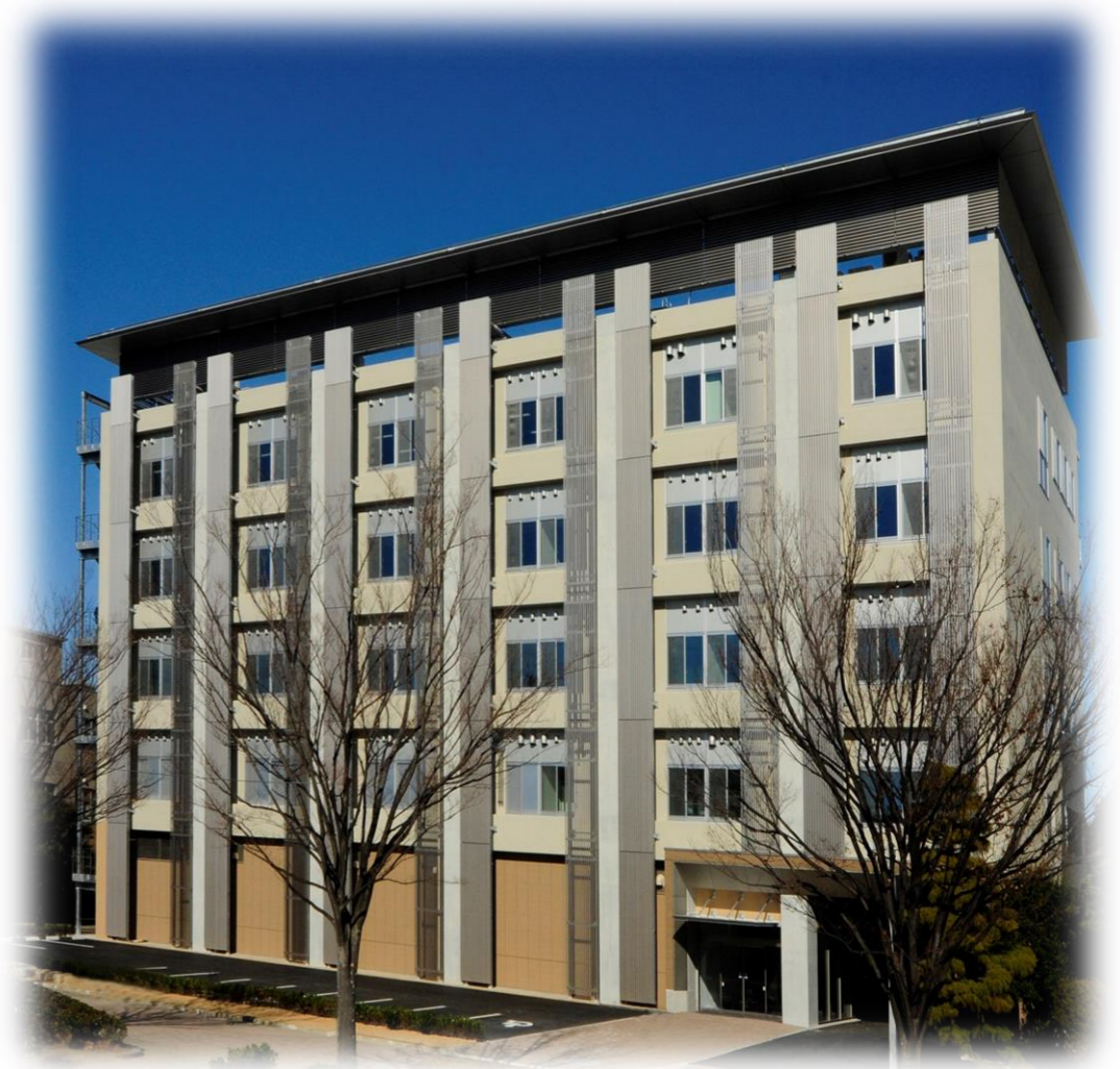
光創起イノベーション研究拠点棟
