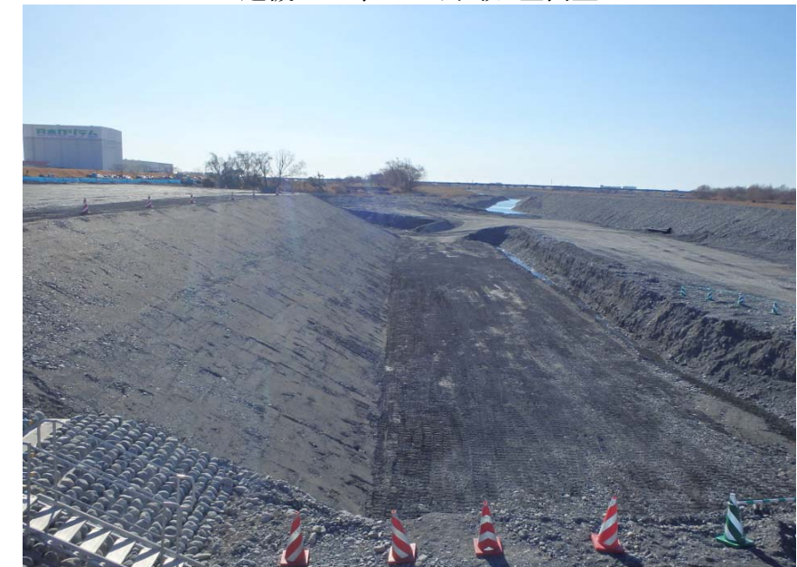
ICT建機による仕上がり状況:基面整正
