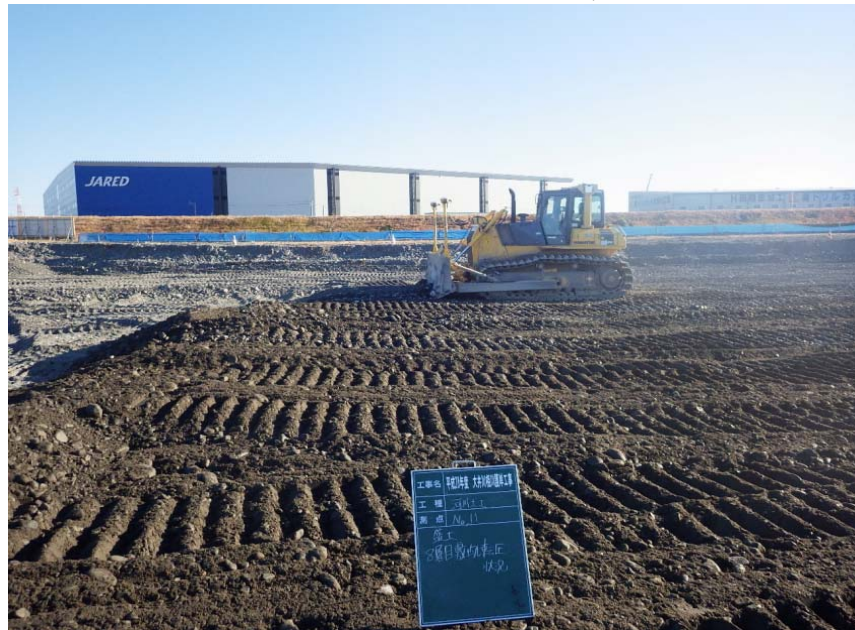
MCブルドーザによる盛土状況
