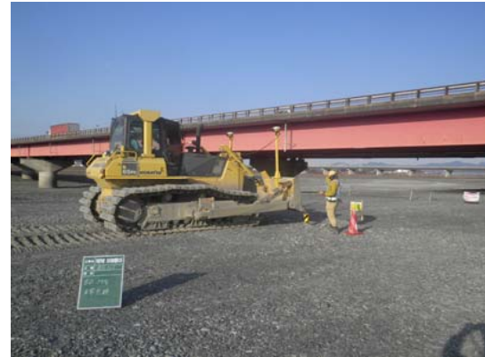
日常点検:ブルドーザ
