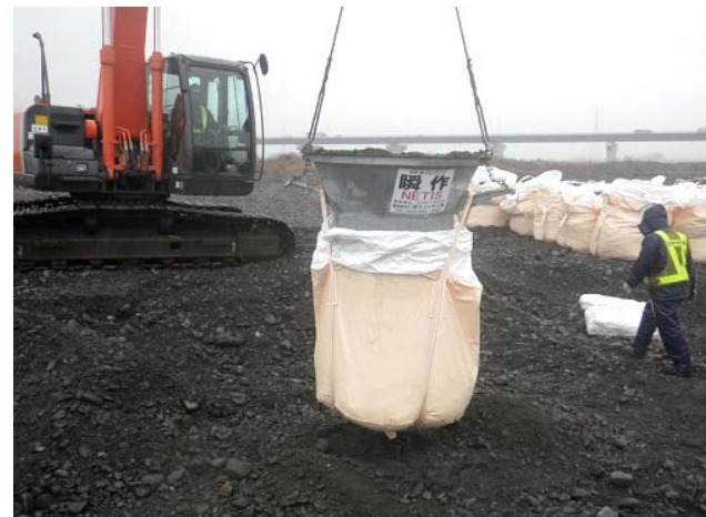
(重機作業のみ)
