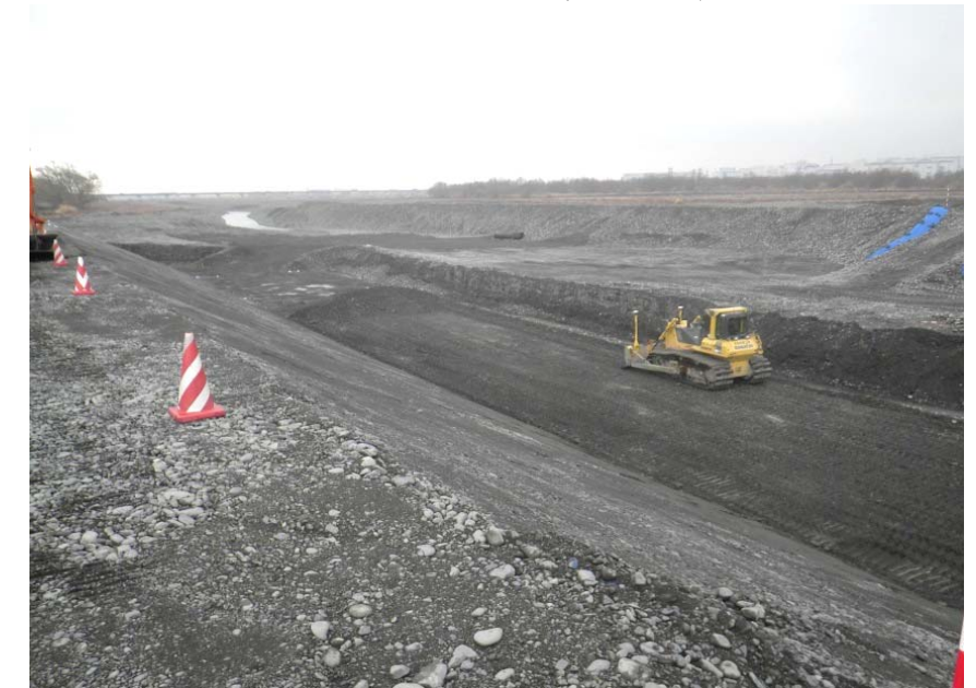
MCブルドーザによる基面整正状況
