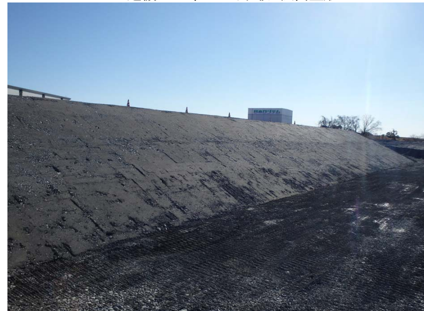
ICT建機による仕上がり状況:法面整形
