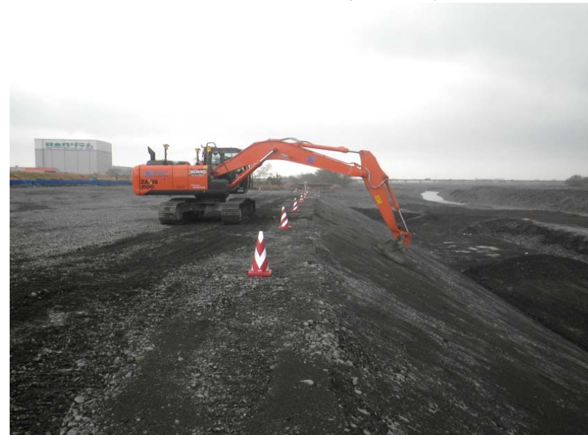
MGバックホウによる法面整形状況
