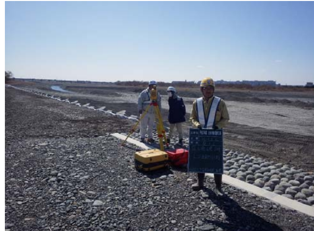
レーザースキャナーによる計測状況
