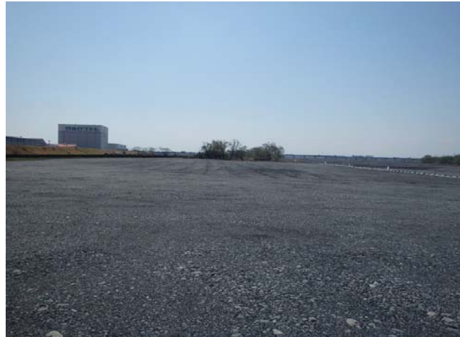
盛土天端仕上げ状況
