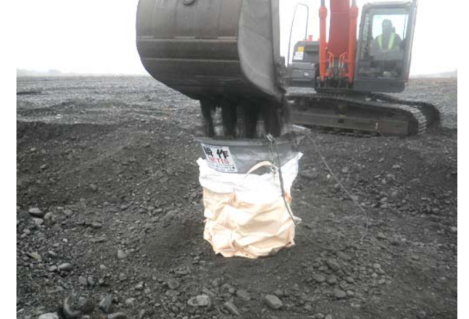
(重機作業のみ)
