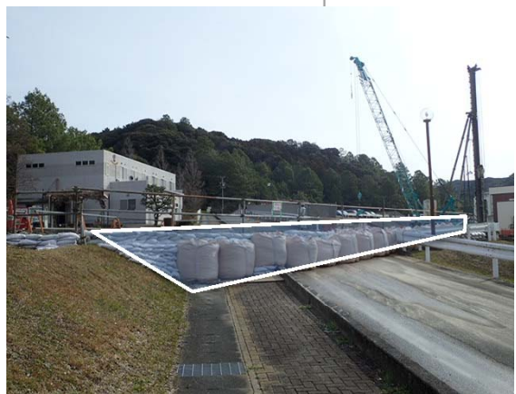
1-④ 乗り入れ部道路勾配による車両傾斜の解消（土留め設置）
