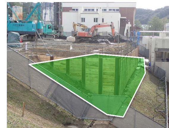
3. 既存法面部本杭打設重機設置水平面確保
