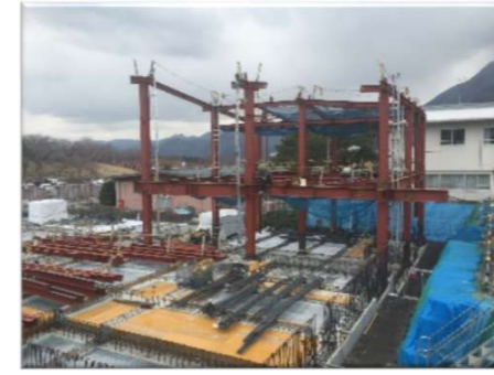
共用棟鉄骨建方
