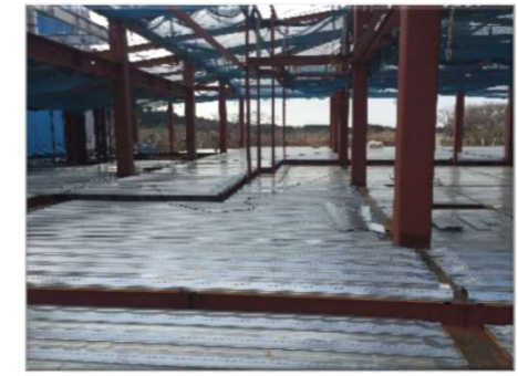
共用棟デッキ敷
