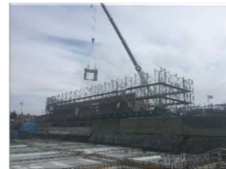
宿泊棟PC板建方
