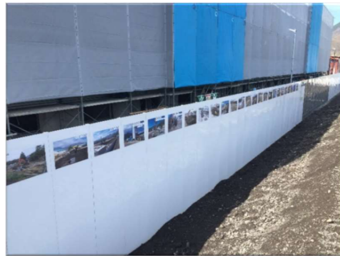
工事進捗状況写真を仮囲へ掲示
