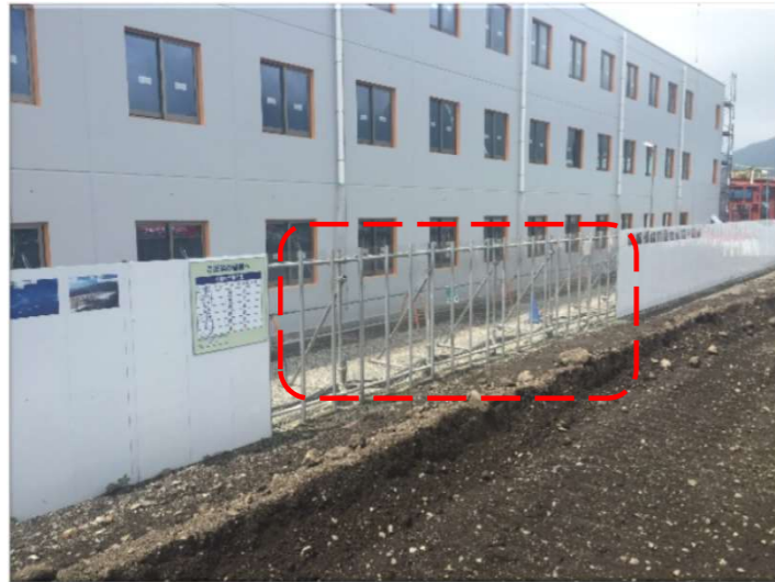
訓練生がいつでも作業所を見学できるように、囲いにクリアパネルを採用
