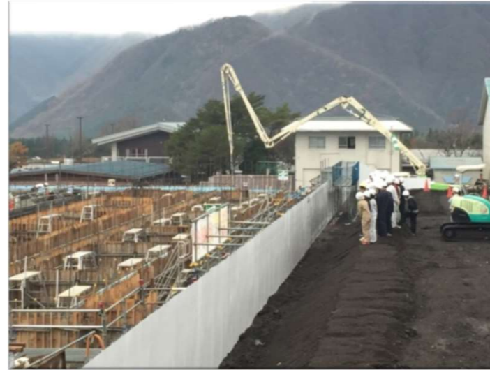
訓練生がコンクリート打設状況を見学している様子
