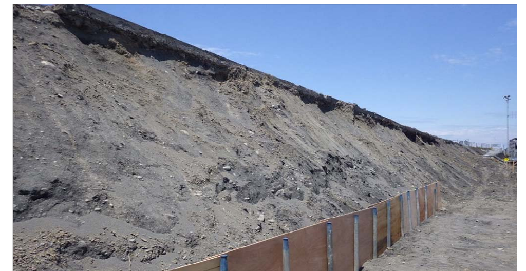
既設構造物撤去後の様子
