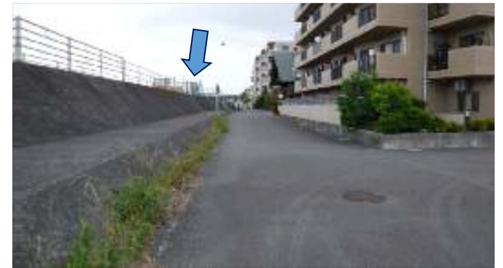
着手前・既設Con構造遊歩道
