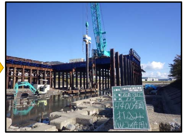
油圧式可変高周波バイブロ+WJ (242Kw起震力389~929KN) 施工数37箇所/87箇所 施工日数12日 日当たり3.08箇所
