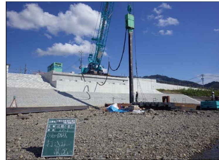
油圧バイプロ(242Kw起震力0~580KN)
