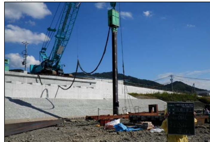
油圧バイブロ(242Kw起震力0~580KN)
