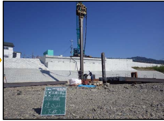
電動バイブロ90Kw 施工数17箇所/87箇所 施工日数10日 日当たり1.7箇所
