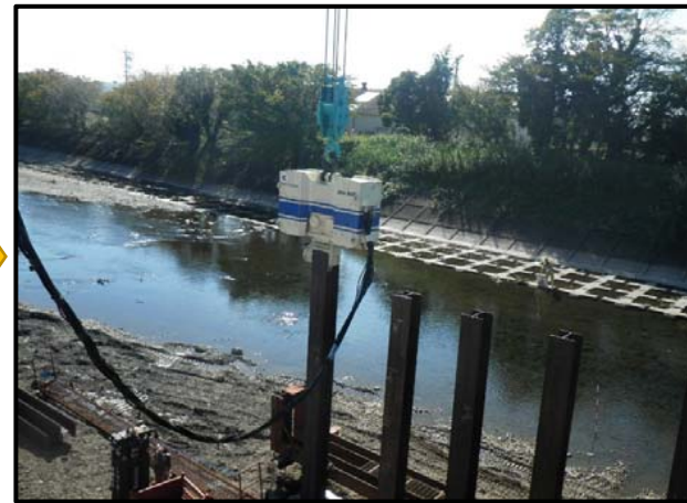
油圧式可変高周波バイブロ (242Kw起震力389~929KN) 施工数33箇所/87箇所 施工日数23日 日当たり1.43箇所
