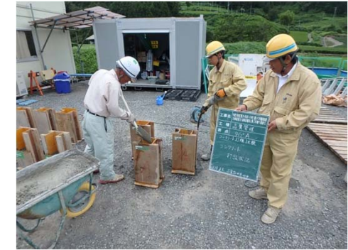
コンクリート打設状況
