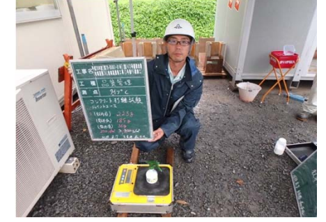
散布量確認状況
