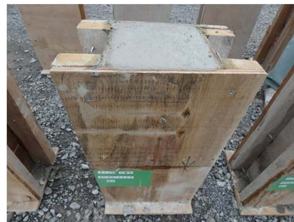
コンクリート打設完了(2回目)
