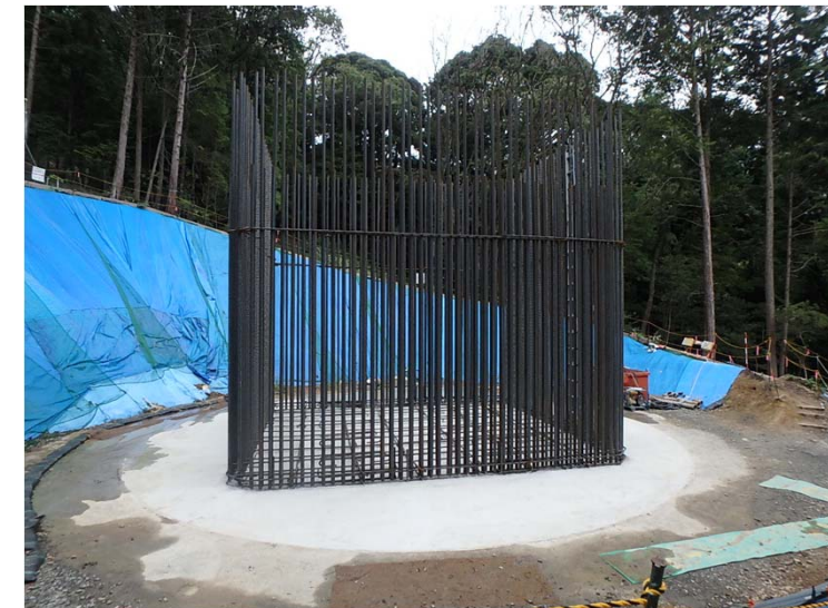
深礎完了全景
