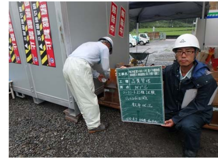
打継処理剤散布状況
