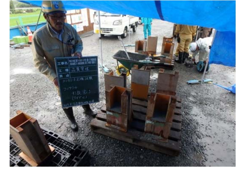
コンクリート打設状況(1回目)
