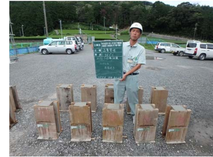
コンクリート打設完了(2回目)
