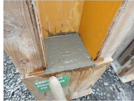
モルタルペースト塗布完了
