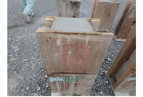
コンクリート打設完了(2回目)
