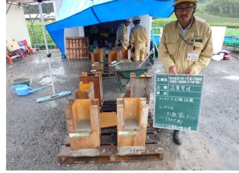
コンクリート打設状況(1回目)
