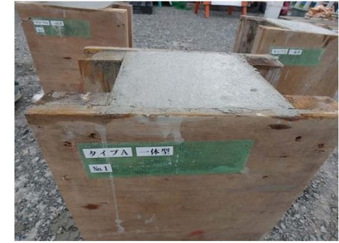
コンクリート打設完了
