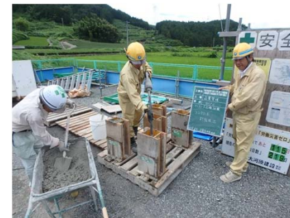
コンクリート打設状況(2回目)
