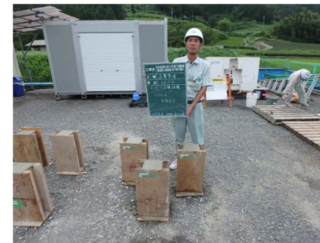
コンクリート打設完了
