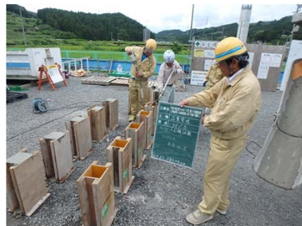
コンクリート打設状況(2回目)
