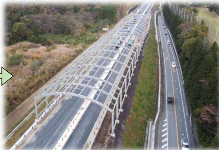
本工事による飛球防護柵施工
