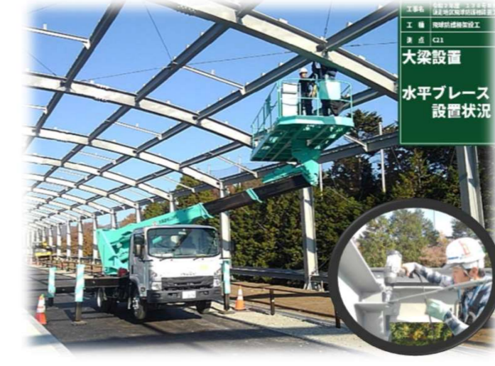
ブレース材設置
