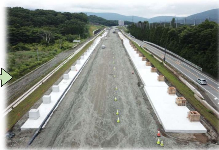
別工事による飛球防護柵基礎施工
