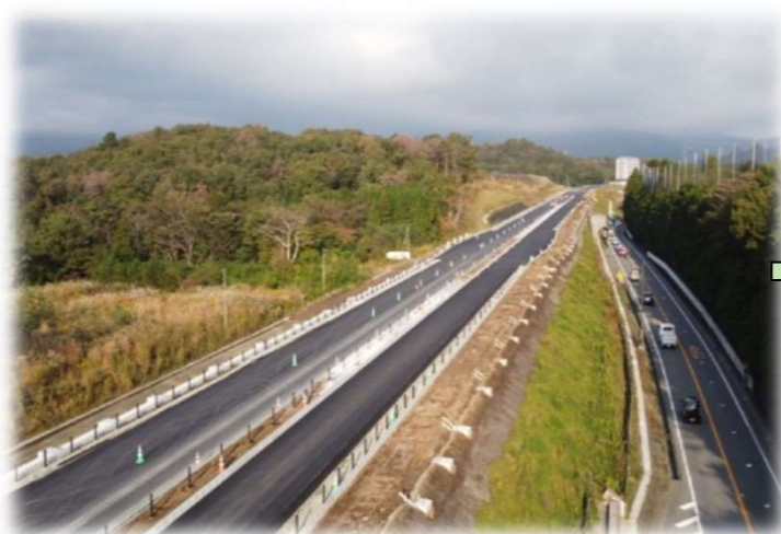
舗装工事による一部施工完了時
