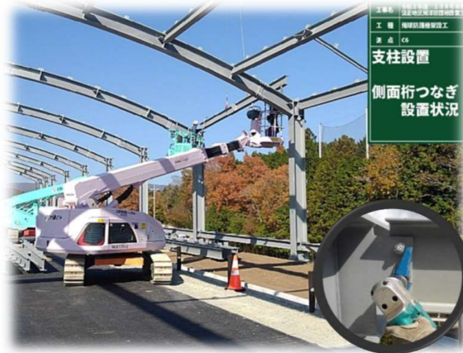
桁つなぎ設置
