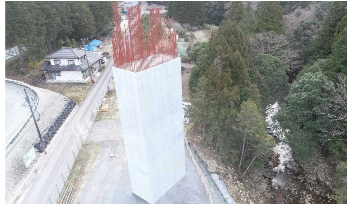
写真-28 7号橋P3橋脚 全景
