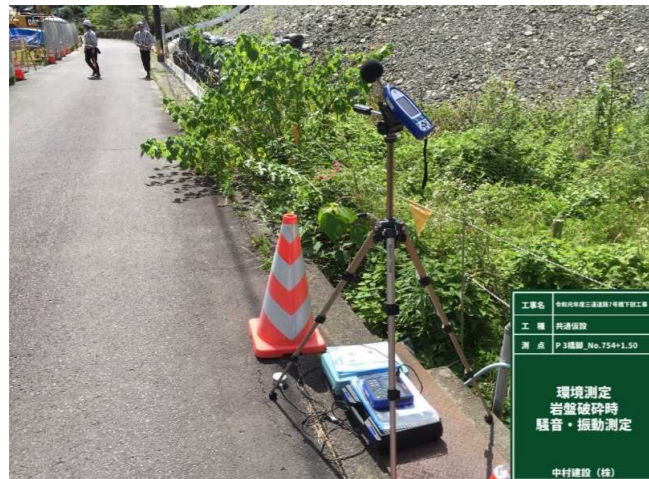
写真-24 岩盤破碎時の騒音・振動計測状況
