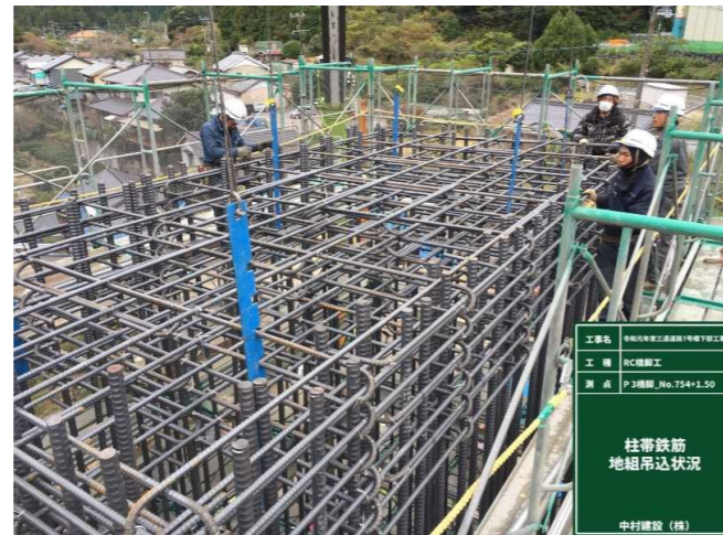
写真-19 帯鉄筋吊込・配筋状況
