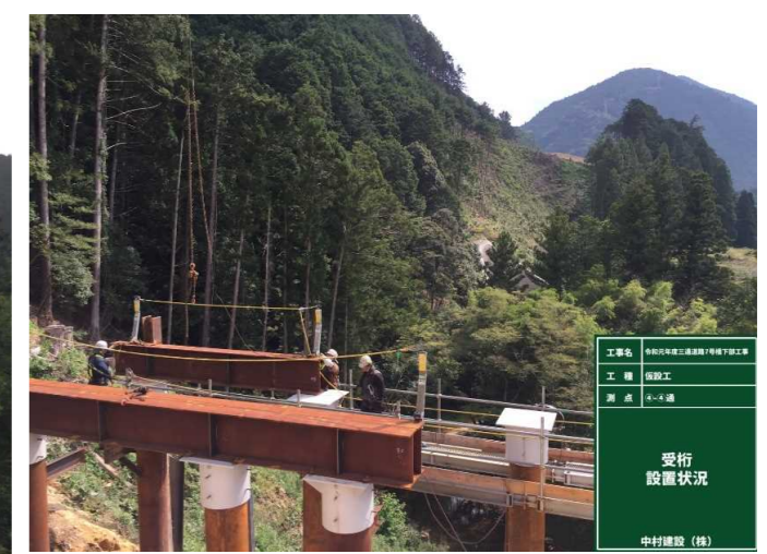
写真-15 杭頭キャップへ受桁設置
