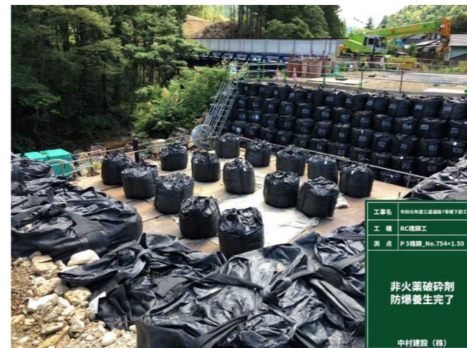
写真-6 防爆養生状況
