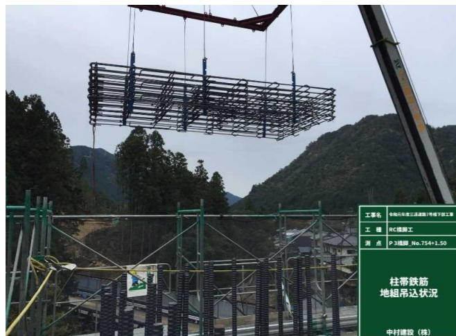
写真-18 吊り治具による帯鉄筋吊込状況
