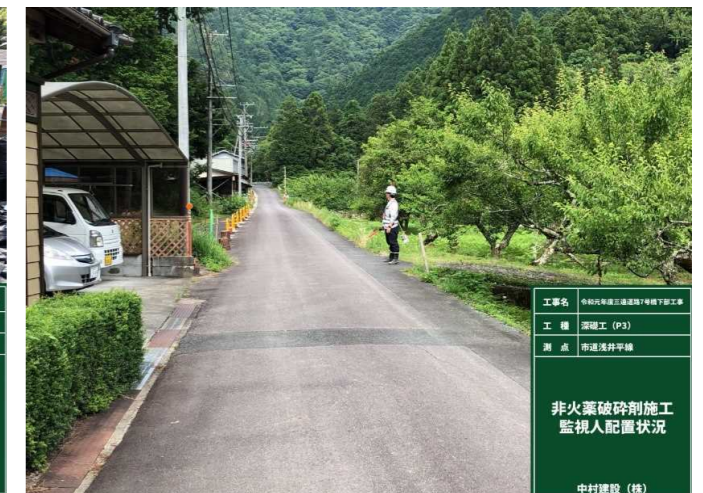
写真-7 破碎時周辺監視人配置
