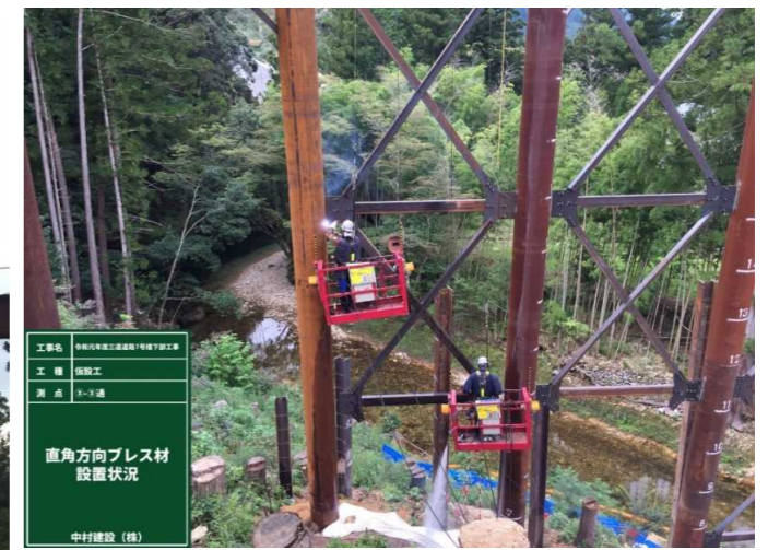
写真-17 支柱補強材取付状況
