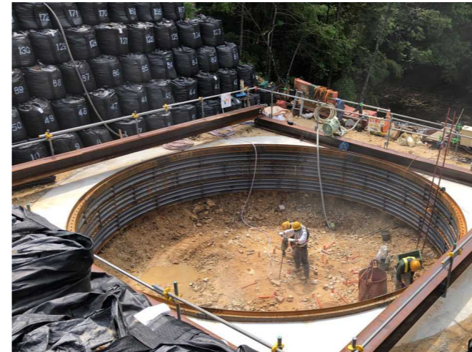
写真-4 装薬孔穿孔状況
