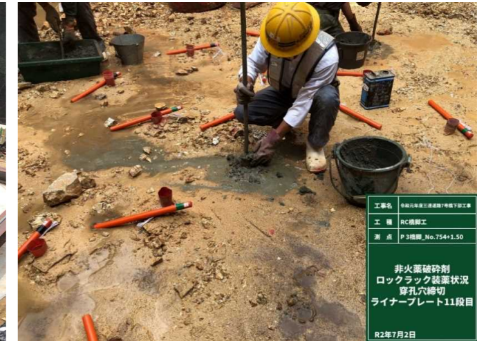
写真-5 非火薬破碎剤装薬状況
