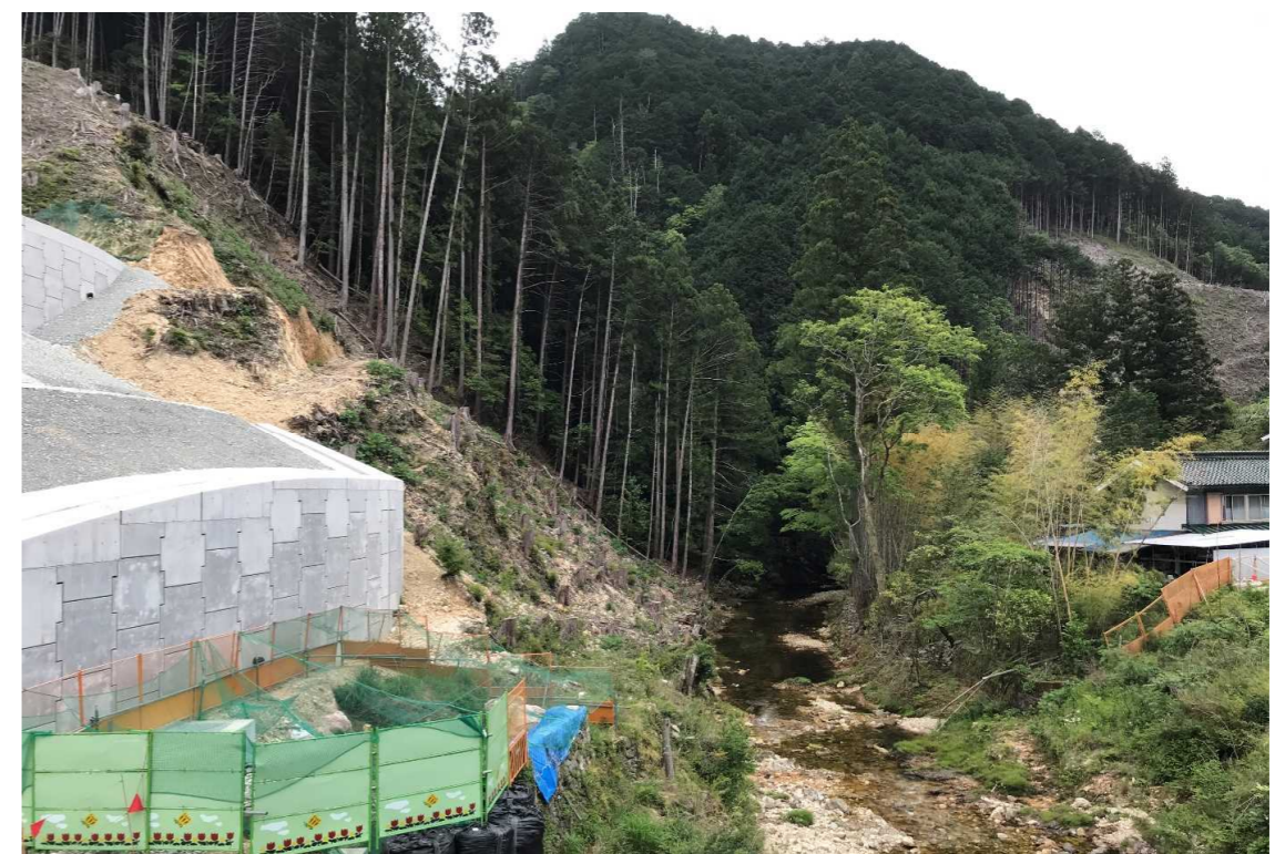
写真-1 仮橋施工箇所
