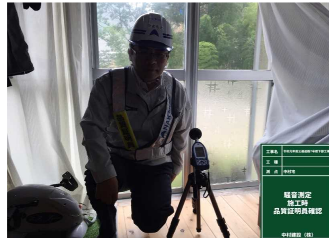
写真-25 ダウンザホール施工時の近隣家屋内騒音計測状況
