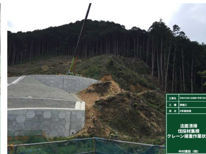
写真-13 クレーンによる根株揚重作業
