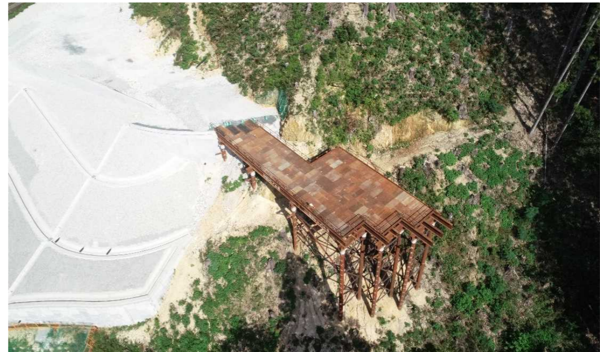
写真-29 8号橋仮橋 全景
