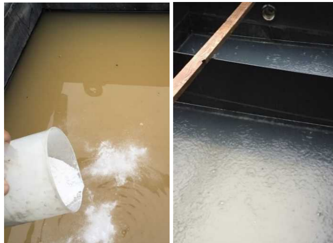
写真-26 無機系凝集沈殿剤による濁水処理
