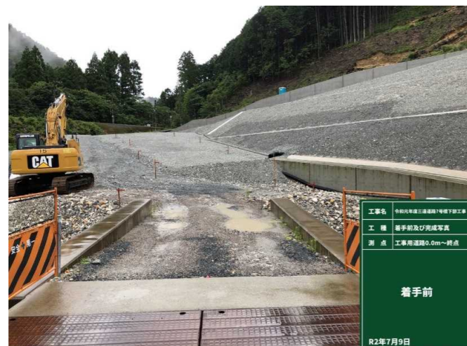
写真-10 工事用道路
