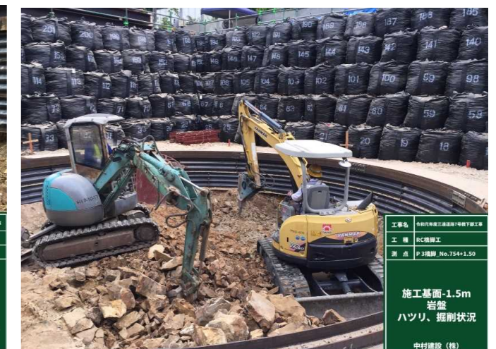
写真-9 ブレイカー併用による掘削
