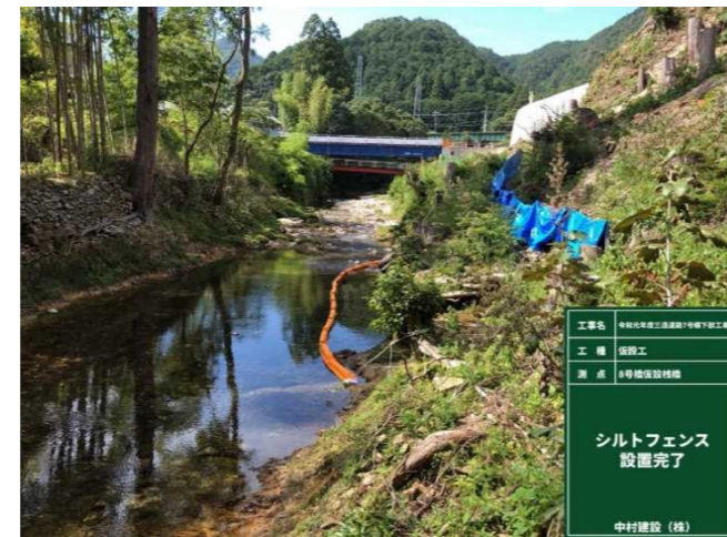
写真-27 土砂止め柵・シルトフェンス
