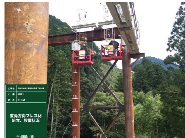
写真-22 架台足場とゴンドラによる施工
