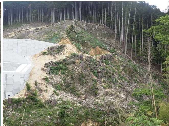
写真-11 補強土壁盛土突縁部（仮橋施
