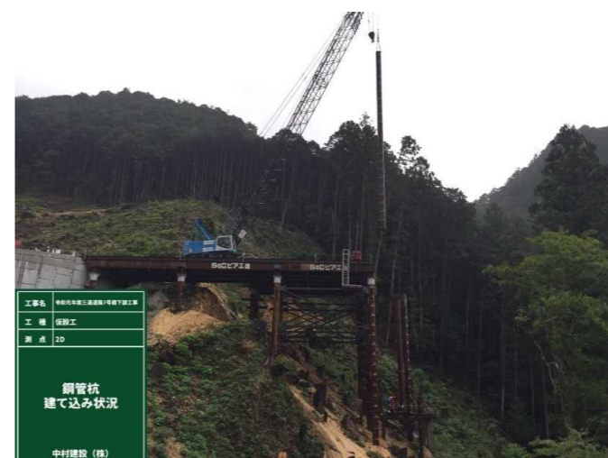
写真-14 Sq cピア杭頭キャップ工法による張出架設状況
