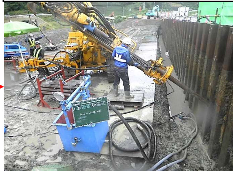
②アンカー工
