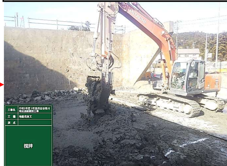
⑤地盤改良工
