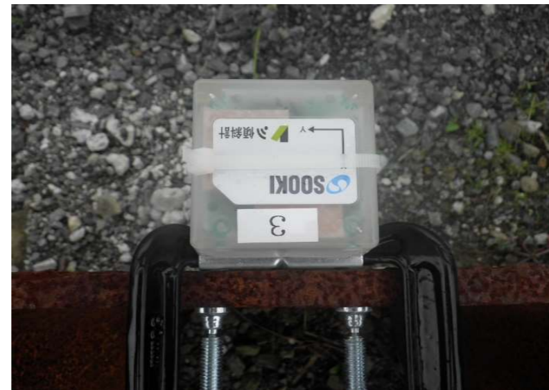
写真-3. 無線式傾斜観測システム近景
