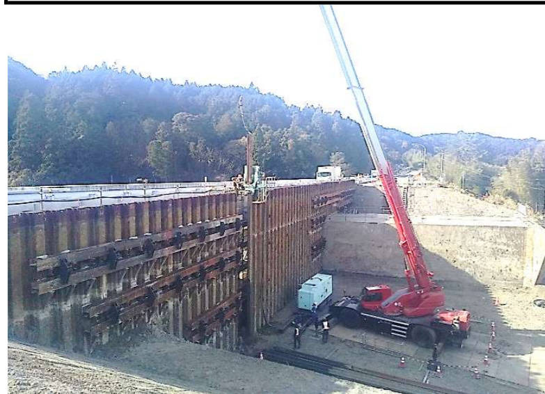
④鋼矢板引抜き
