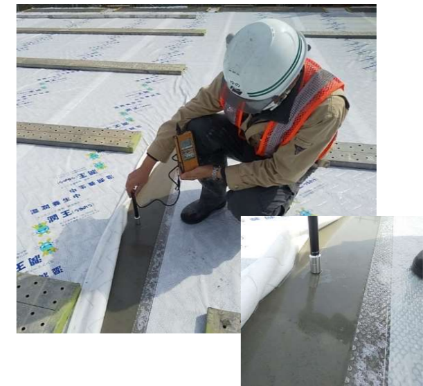
写真-10. コンクリート温度測定状況
