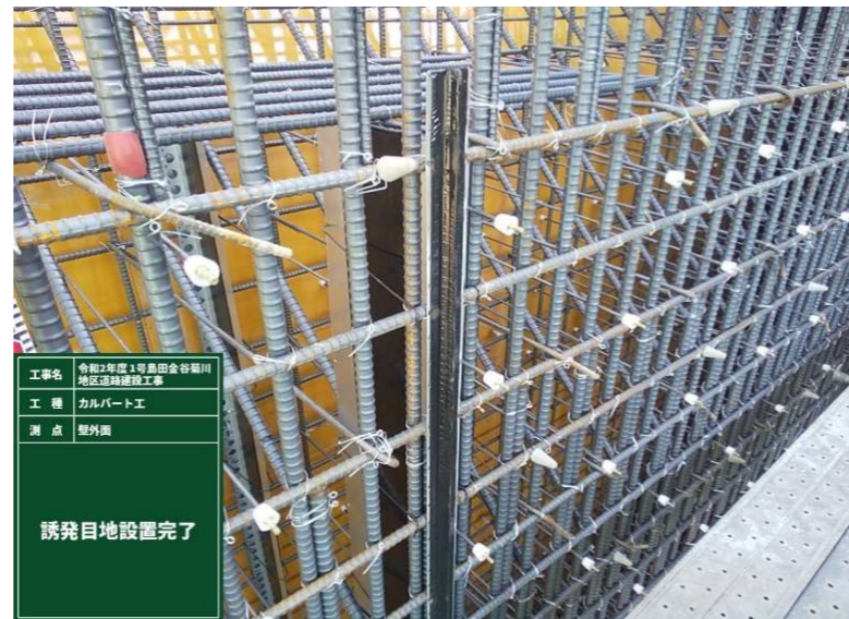
写真-8. 誘発目地設置状況
