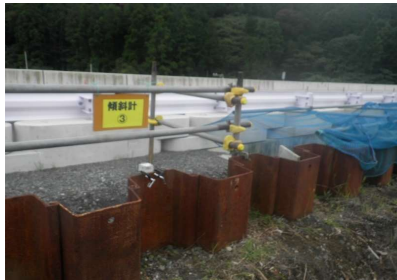
写真-2. 無線式傾斜観測システム設置状況
