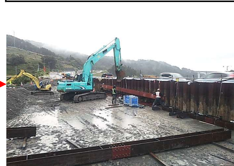
③土留め支保工
