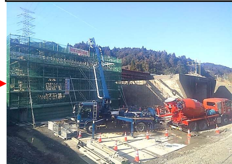
⑥カルバート工
