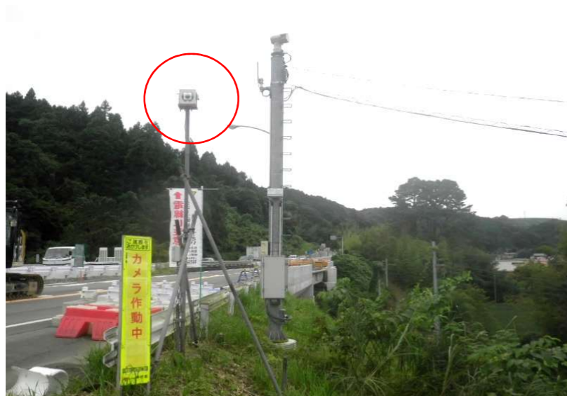
写真-5. Webカメラ設置状況
