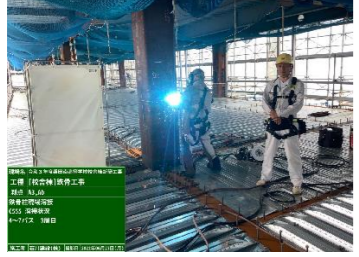
▲柱接合部現場溶接状況
