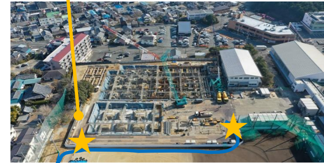
グラウンド散水配管より分岐
