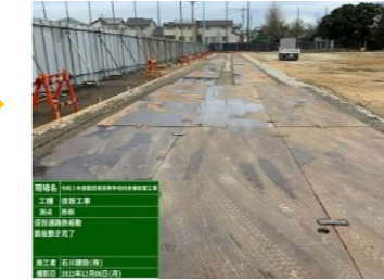
③鉄板同士をズレ止め鉄板固定
