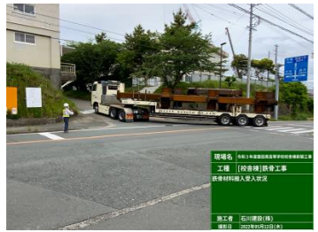
▲鉄骨搬入トレーラー状況
