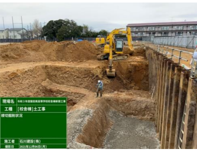
▲ 貯水ピット掘削状況
