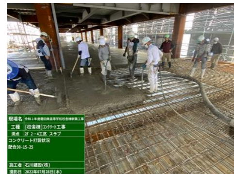
▲ スラブ生コン打設状況
