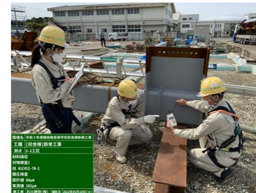
▲ 鉄骨製品受入検査実施状況
