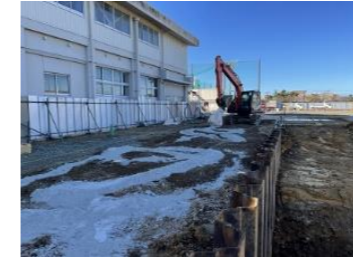
※軟弱地盤箇所はセメント改良実施
