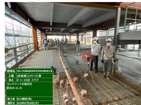
▲ スラブ上打設配管状況
