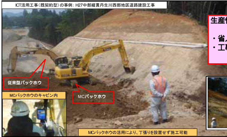
MCバックホウの活用により、丁張りを設置せず施工可能
