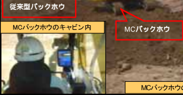
MCバックホウの活用により、丁張りを設置せず施工可能
