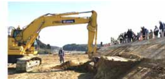
丁張り不要の圧倒的な施工効率を体感
