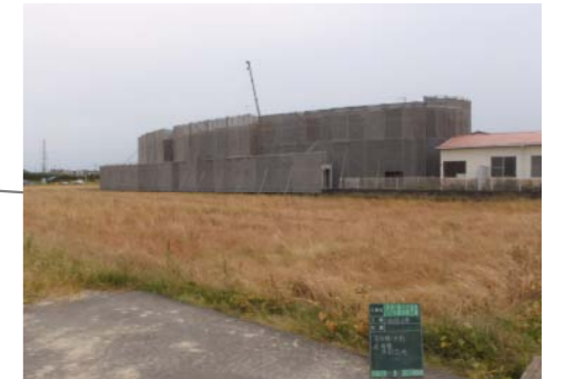
↑北側の田園の隅をお借りして足場を建てました
