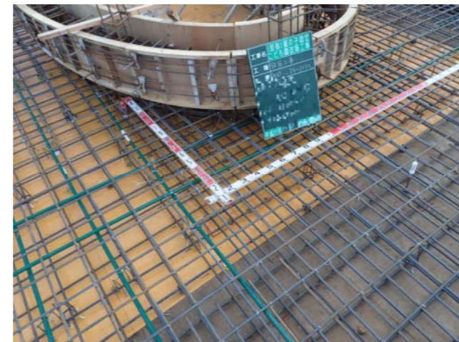
RFスラブにてPC鋼線配置状況
