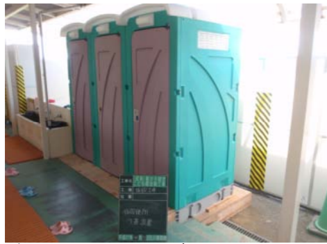
↑園児用トイレが減ったため園児の仮設トイレを設置
