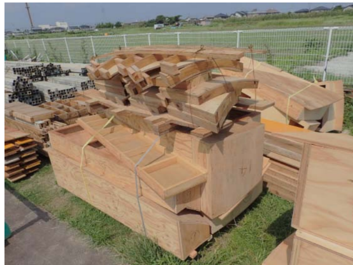
曲線の型枠材
