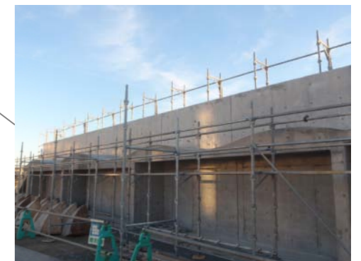
↑本園舎躯体工事が完了すると東側の「屋外倉庫」着手です
