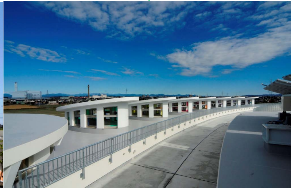
屋上：津波避難施設 左側：各教室の高窓 右側：ソーラ発電10kWh
