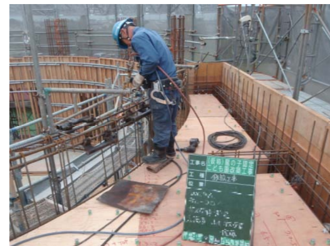
現場鉄筋圧接工事状況
