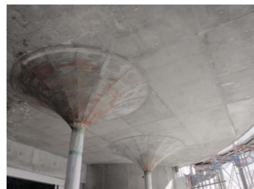
脱型した状況です
