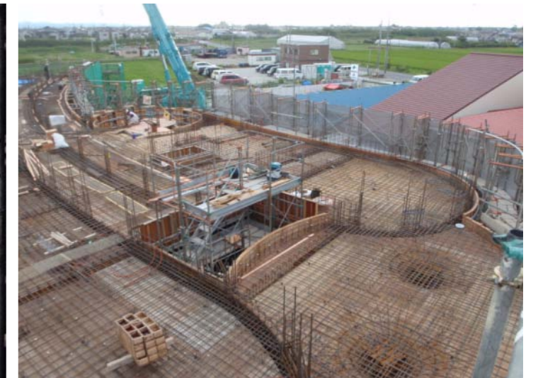
躯体工事状況
