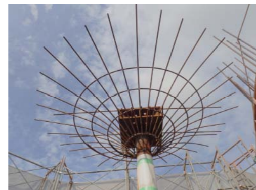
鉄骨に鉄筋受けを溶接し配筋しました
