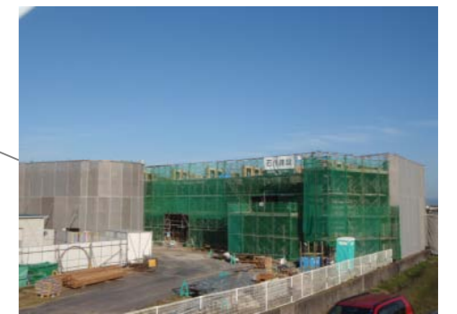
↑工事I17めいっばいに建ち曲線に合わせた足場組です
