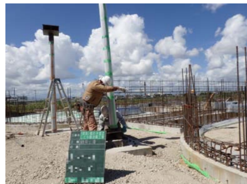
柱は鉄骨SS400 160のムク材です
