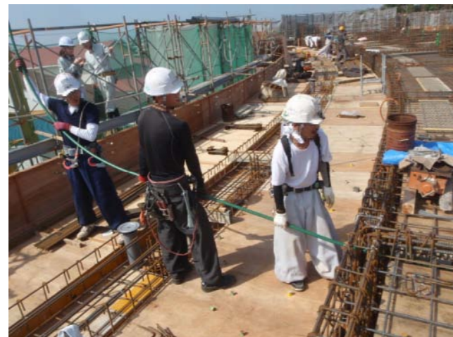
RF梁にてPC鋼線設置状況
