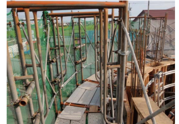
外部足場組立状況
