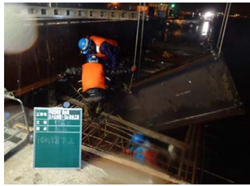
上部工：H型鋼係船柱架台
