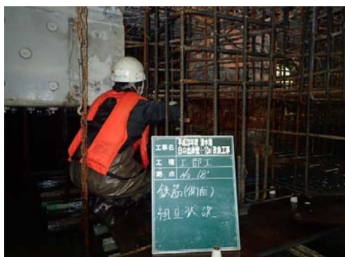
上部工：鉄筋組立
