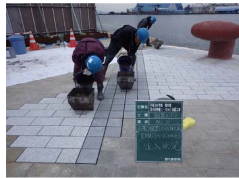
舗装工：支持層充填
