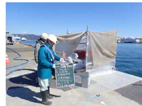
付属工：係船柱塗装(中塗り：CVスプレー)
