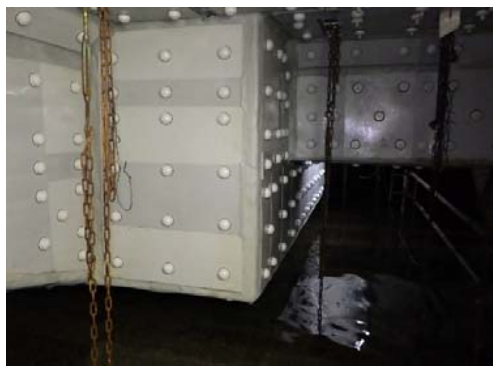
電気防食工：亜鉛防食板設置
