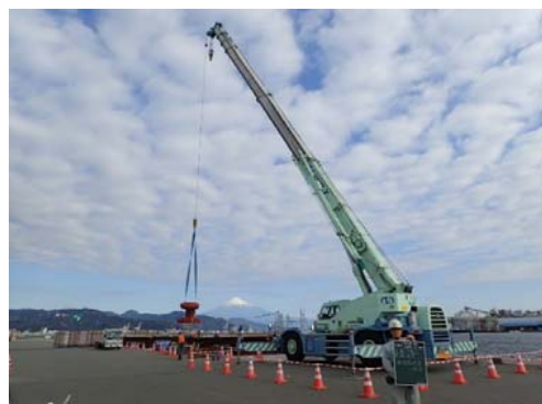
付属工：係船柱設置
