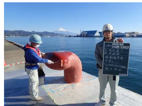
付属工：係船柱塗装(下塗り：プライマー)
