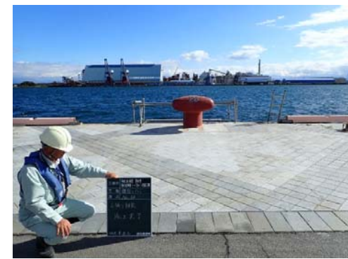
舗装工：石張舗装完了
