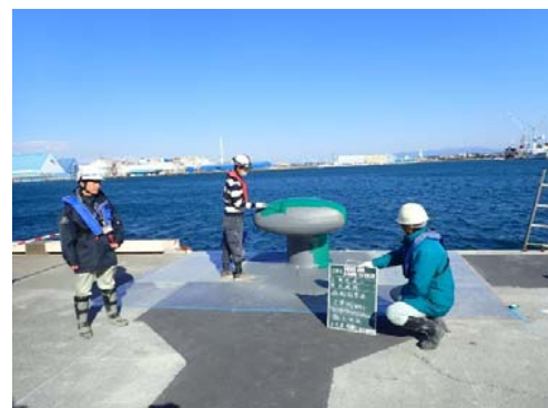
付属工：係船柱塗装(上塗り：レジトップ)
