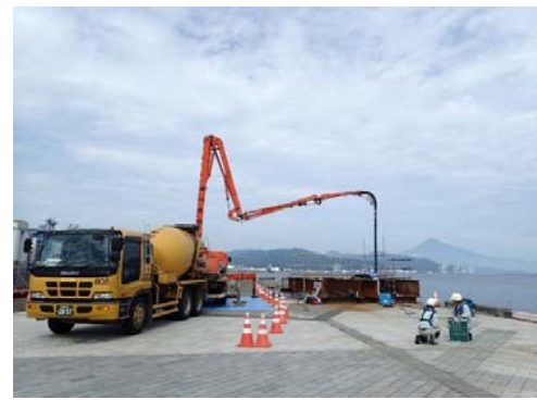
上部工：コンクリート打設
