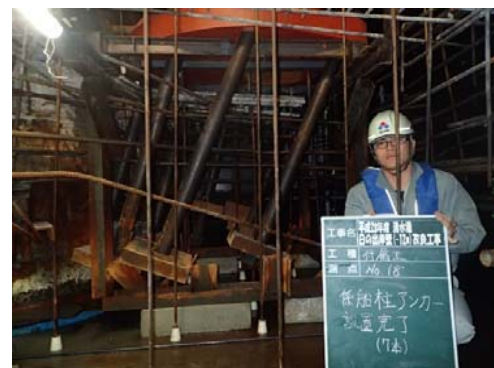
付属工：係船柱アンカー設置
