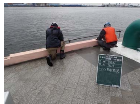
付属工：車止め設置
