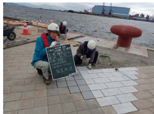
舗装工：石張り工
