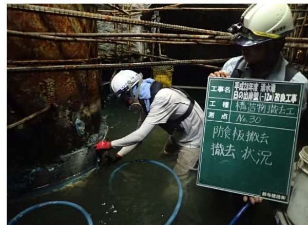
写真-3 干潮帯における施工状況写真
