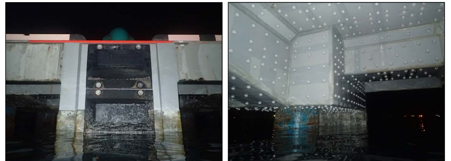
写真-2 完成写真(左:正面、右:岸壁下面(側面))
