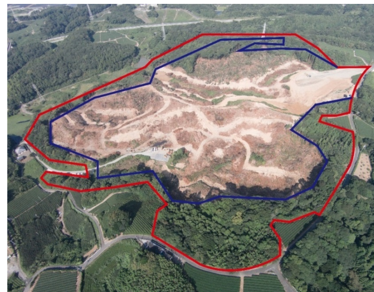
写真11 - 3Dモデル作成時の現場状況(空撮)
