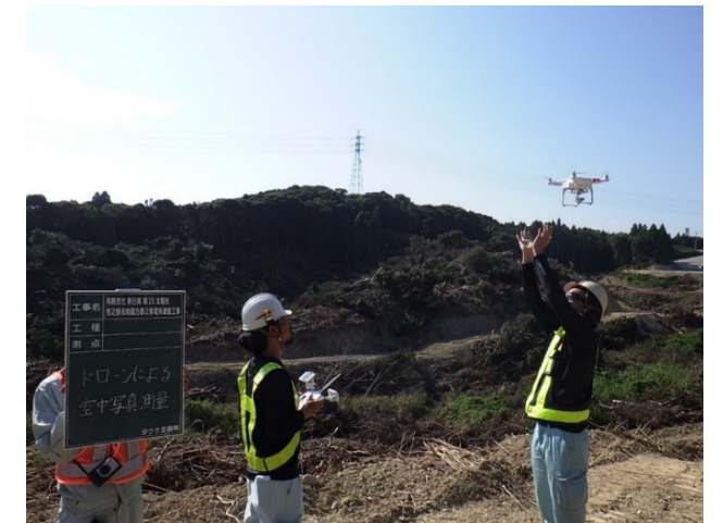
写真9 - UAVによる空中写真測量
