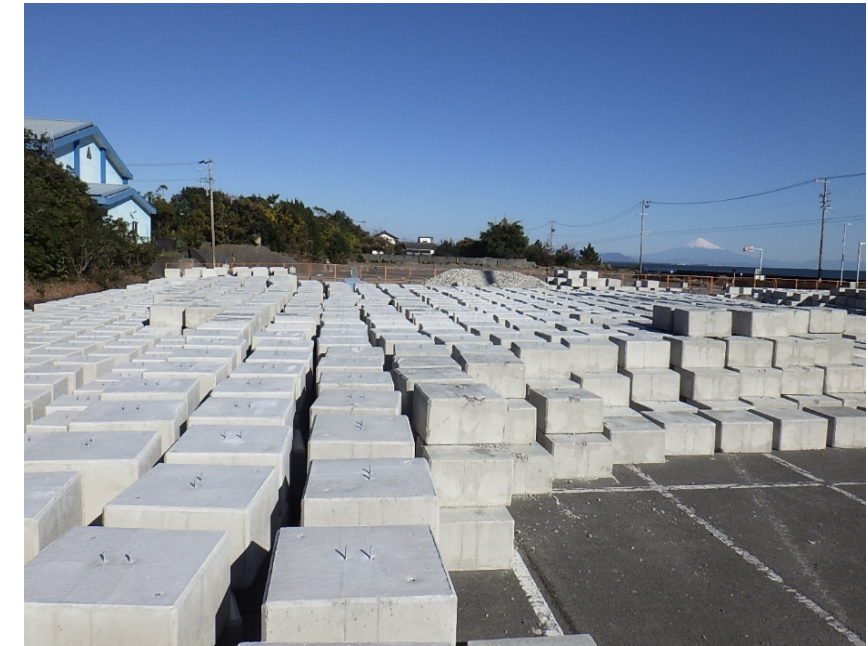
写真14 - 別ヤードで作成した架台基礎
