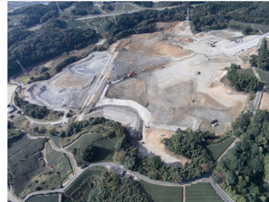
写真6 造成状況 (空撮)
