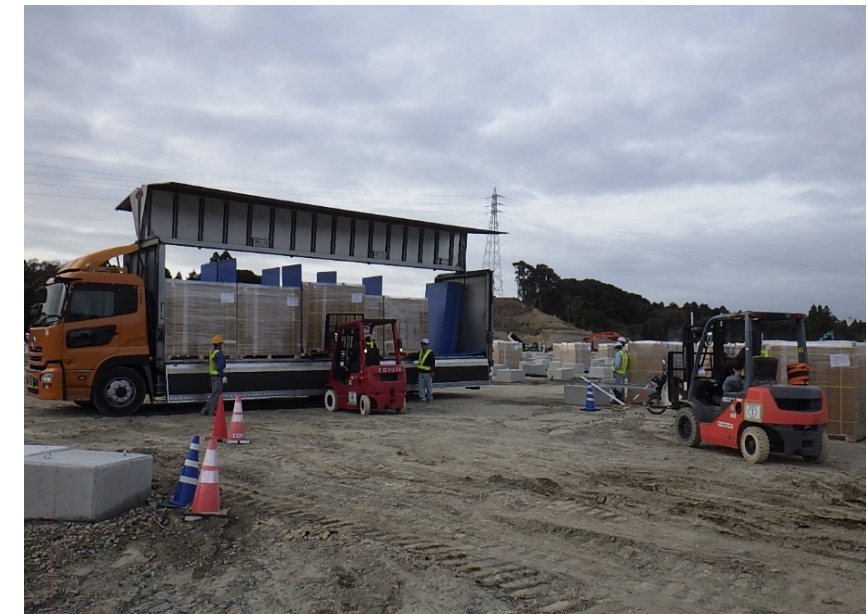
写真15 - 太陽光パネル荷取り
