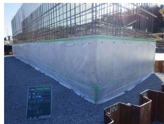
写真-11 ポリシート養生
