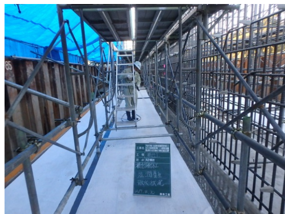
写真-5 養生マット+散水
