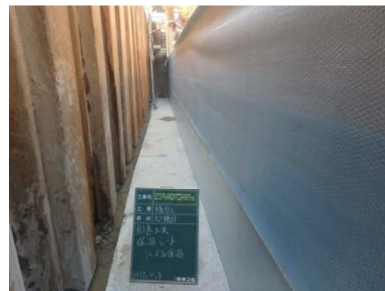
写真-6 脱型後養生(気泡緩衝材)
