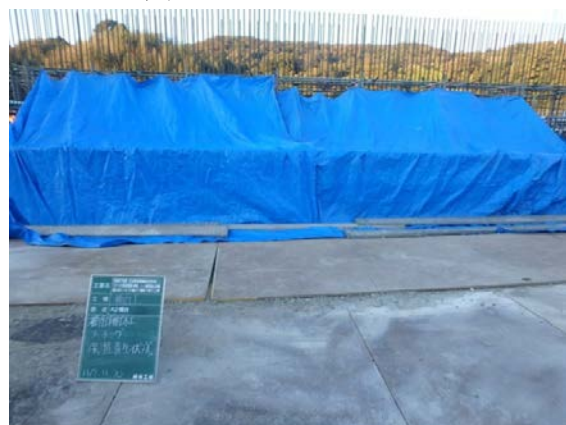
写真-3 ブルーシート養生
