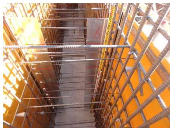
写真-8 誘発目地設置完了
