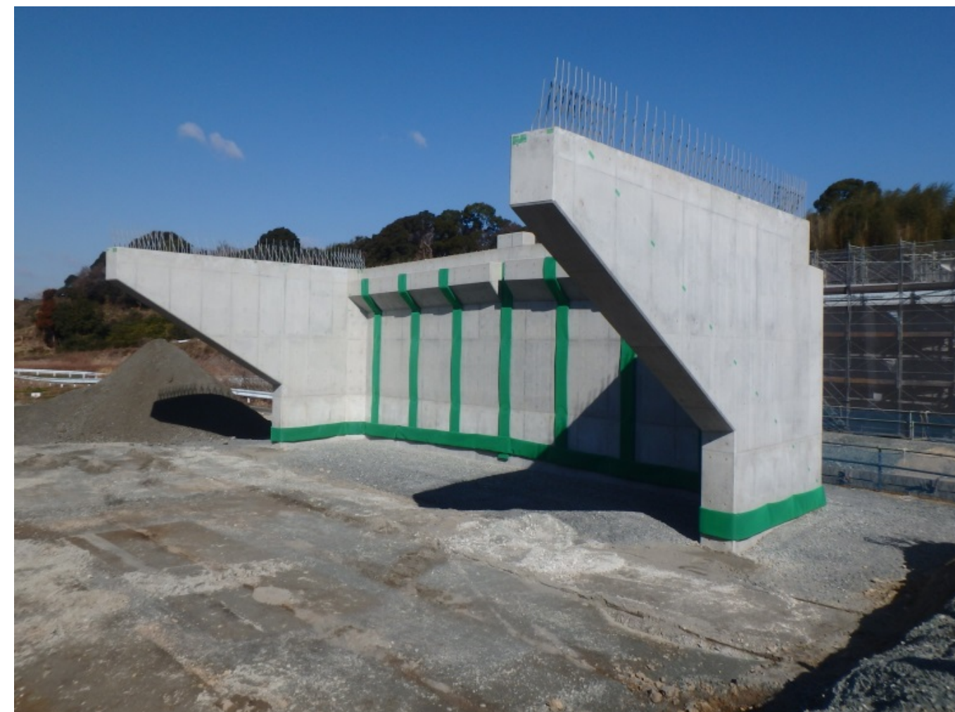
橋台完成(背面)
