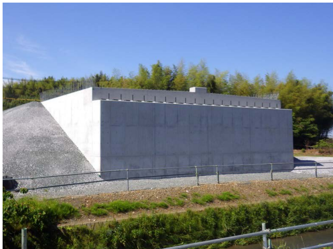
橋台完成(前面)
