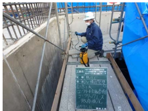
写真-10 養生剤散布状況
