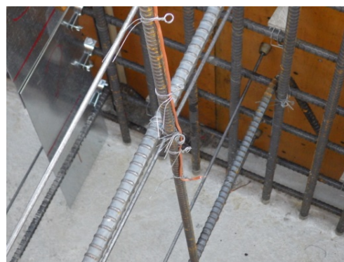
写真-2 内部温度測定センサー
