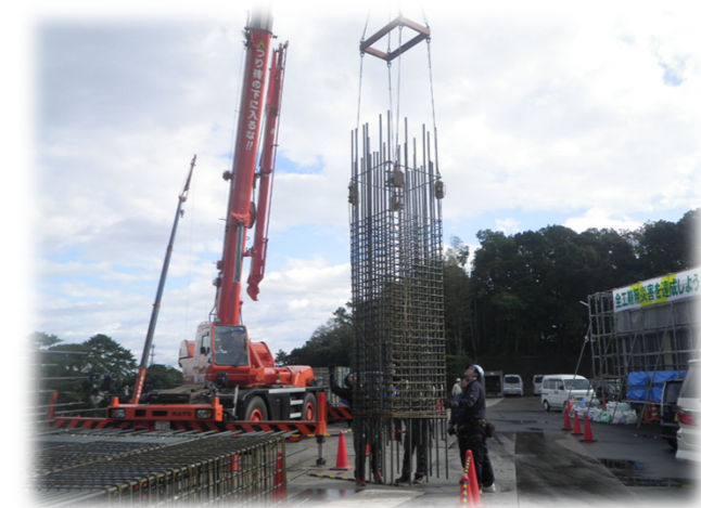
ユニット材吊り込み
