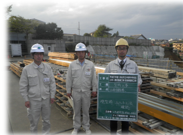
大型ユニット型枠
