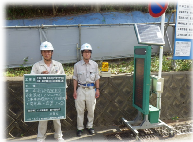
【工事車両退出感知式電光掲示板】
