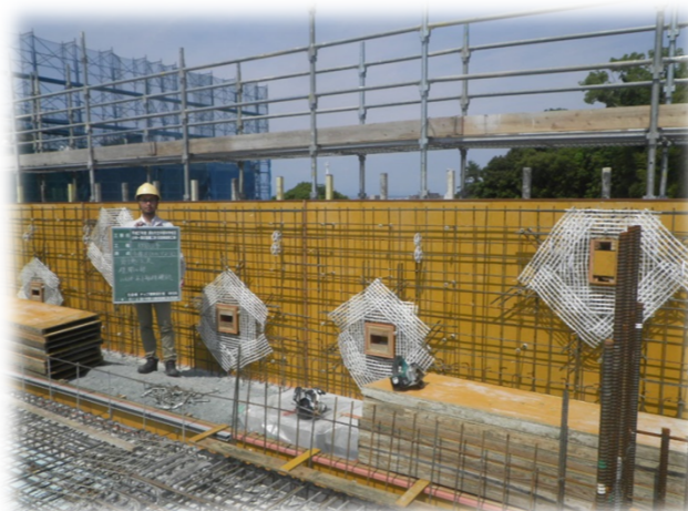
【コンクリートひび割れ低減材の採用】
