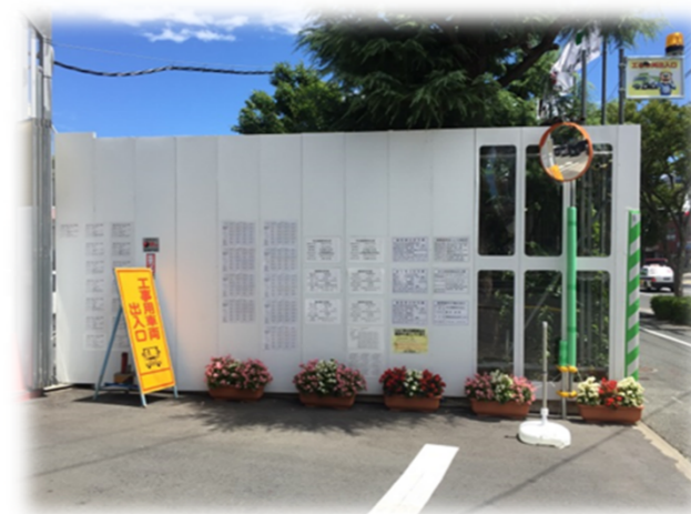
【クリアパネル・プランター設置】
