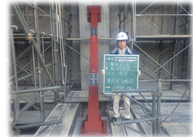
仮設サポート鉄骨
