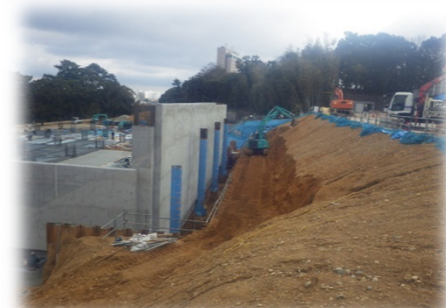
土留壁完了・南棟着手
