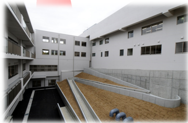
屋外スロープ
