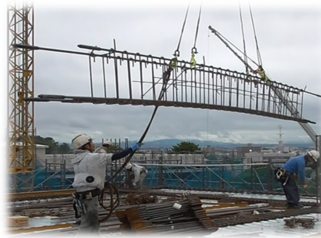
ユニット材吊込み
