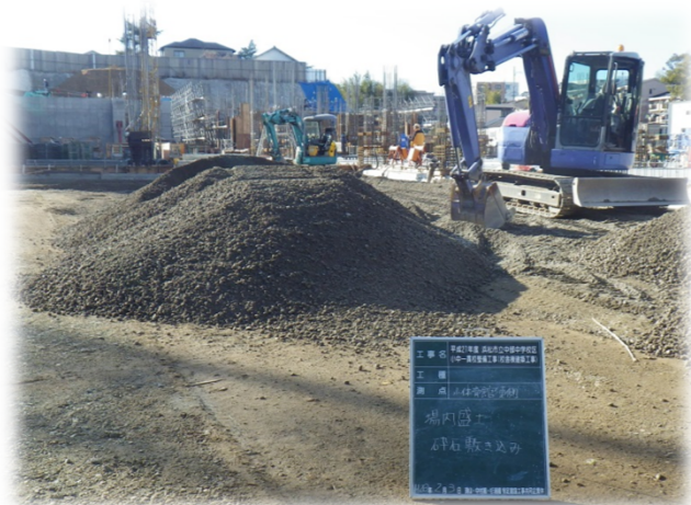
【場内盛土に再生砕石を使用】
