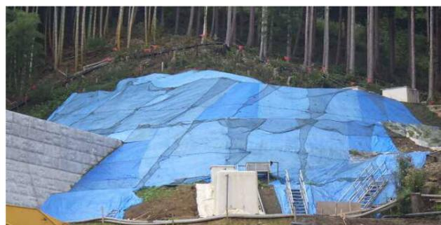
盛土法面の養生（植生工施工までの保護）
