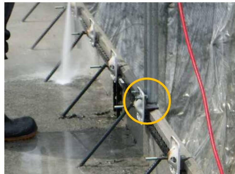
残存型枠の連結金具に、専用治具をボルトにより固定（転用可能）
