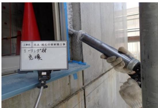
サッシシール（2回目：サッシ外断熱取合）
