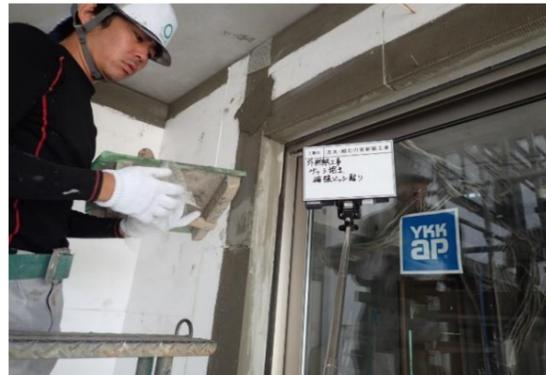
サッシ抱き周り断熱材施工完了
