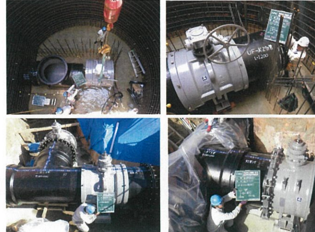
仕切弁設置工
