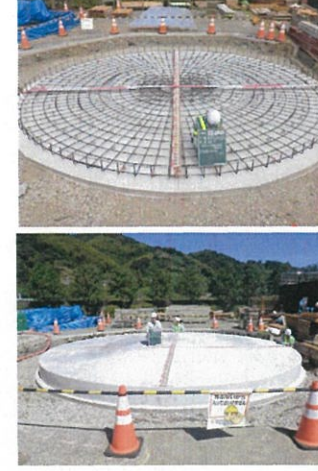
仮設着水井基礎工
