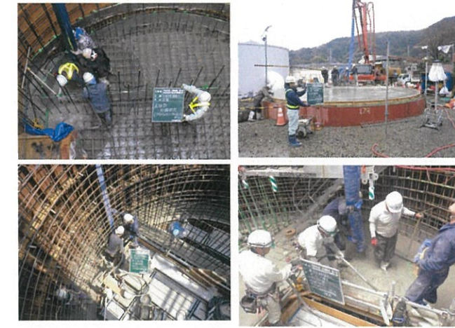
コンクリート打設
