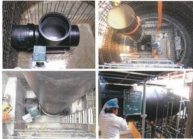
鋳鉄管布設工
