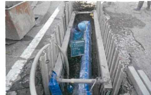
水道管の埋設状況
