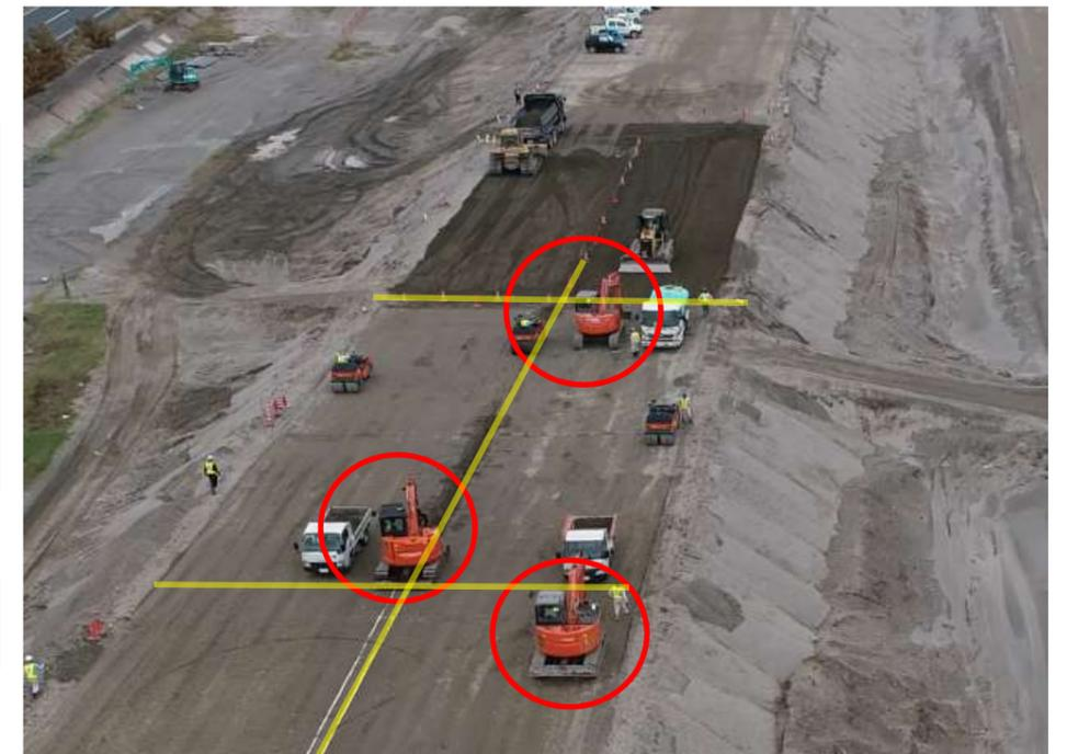
写真-8 CSGマット全景 目地工バックホウ3台同時稼働
