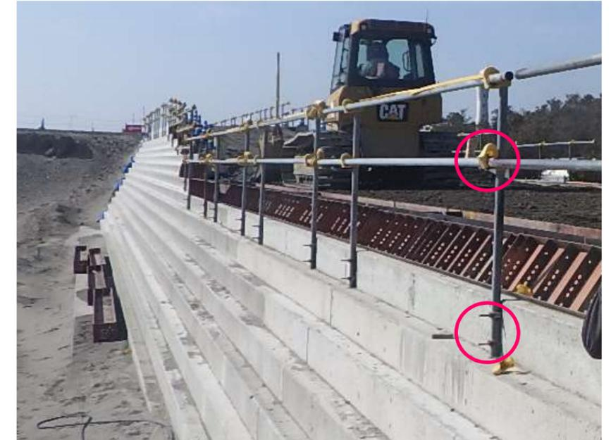
写真-13 堅固な単管パイプでの転落防止柵
