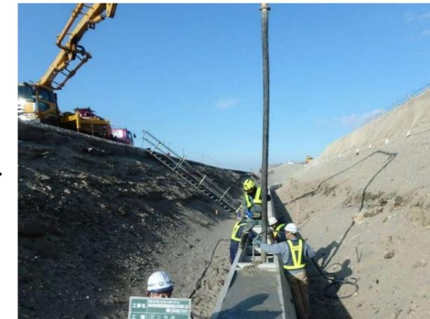
写真-19 笠コン工 中詰コン打設状況
