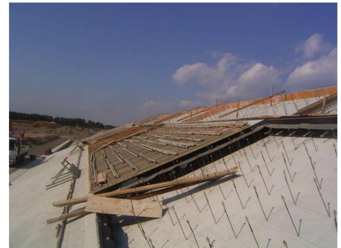
写真-5 他工事 法面被覆 型枠組立状況
