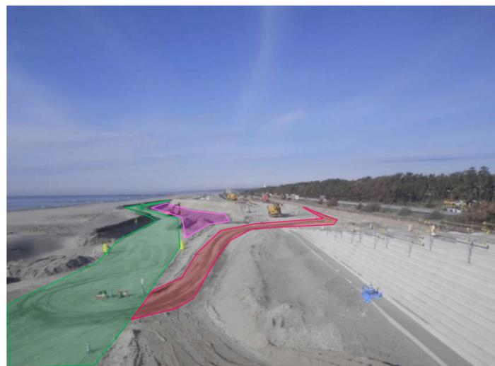
写真-9 起点側の腹付盛土による新規進入路
