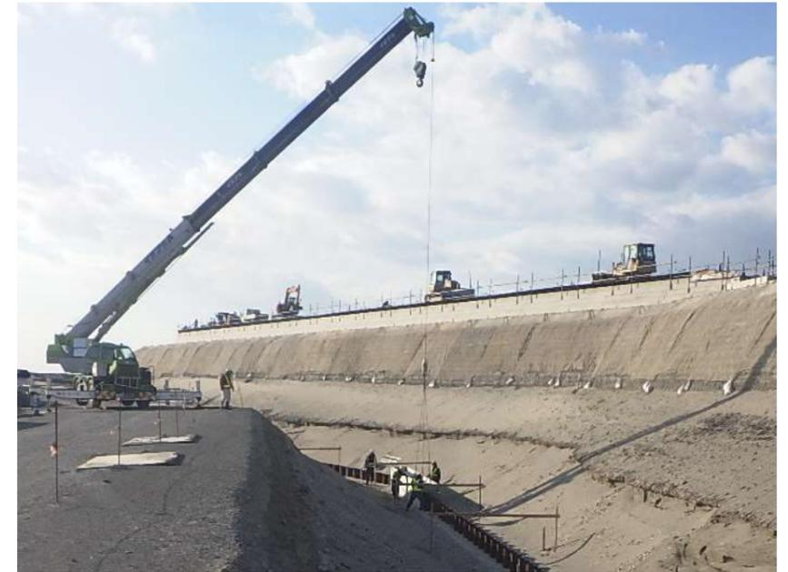
写真-16 上段CSG盛土と下段笠コン据付の同時作業
