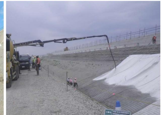
写真-20 布製型枠工 中詰コン打設状況
