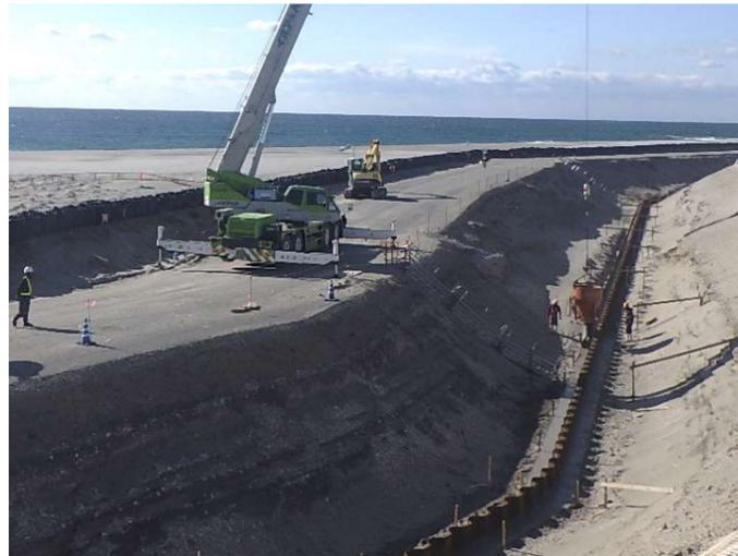
写真-3 笠コン 均しコン施工状況
