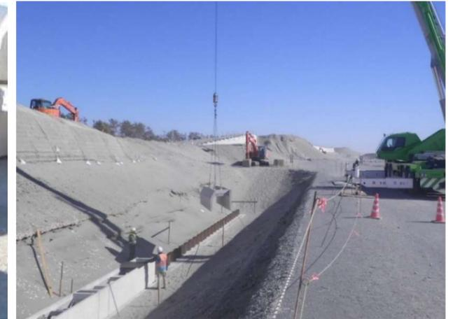
写真-18 笠コン工 製品据付状況
