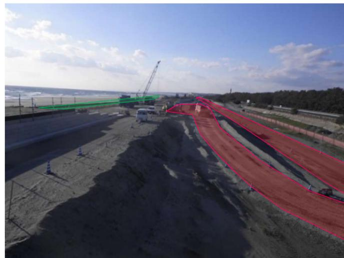
写真-10 Bブロック北側の腹付盛土による新規進入路
