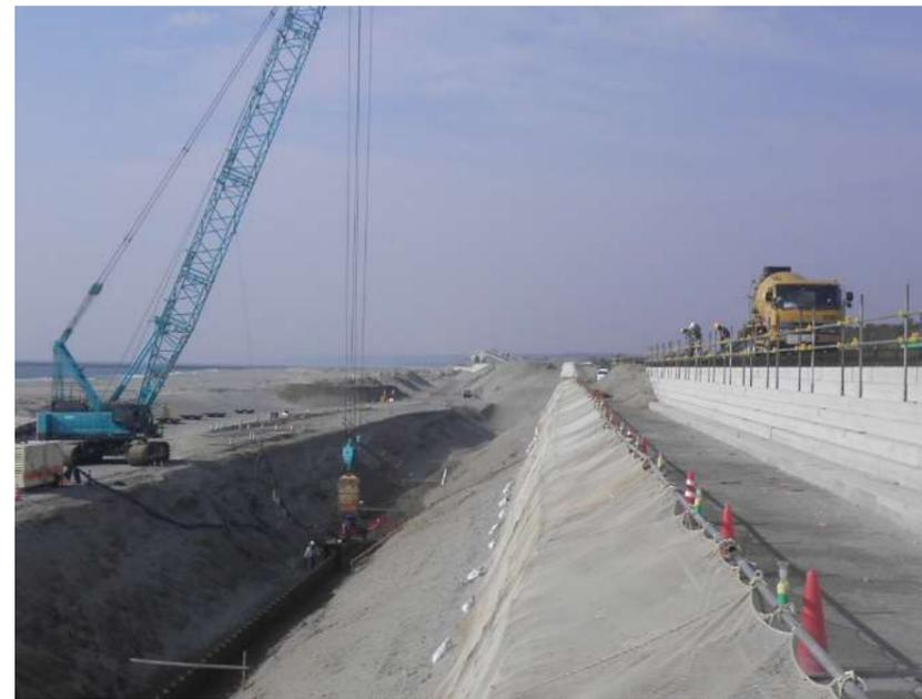
写真-15 上段Co打設と下段矢板打込の同時作業
