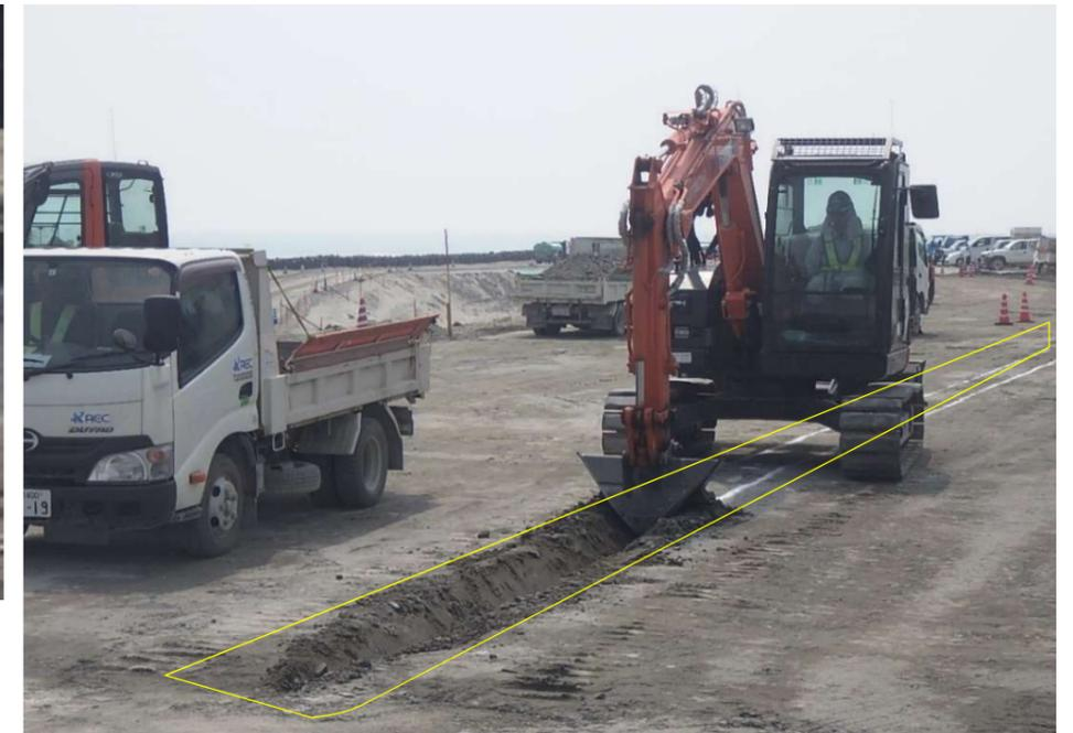
写真-7 目地専用バックホウ掘削状況
