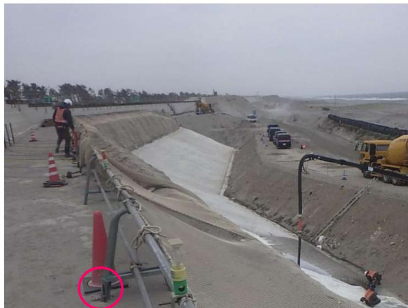
写真-14 鉄筋固定の単管バリケードと保護ネット
