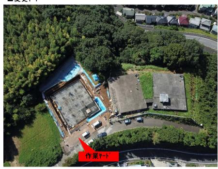
⑥課題 マスコンクリートによる温度ひび割れ発生が懸念された。(配水池基礎打設量 V=520m3/回)
