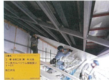
新規GL鋼板張り
