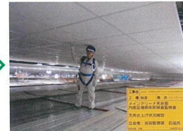
軽量天井完了検査
