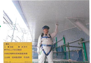
軒天完了検査
