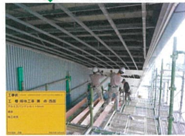
既存軒天撤去
