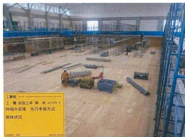
内部棚足場組
