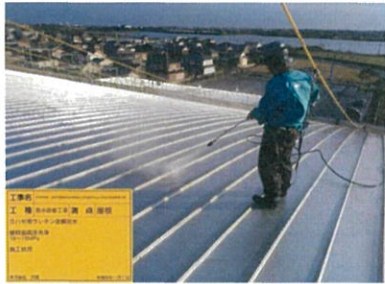
既存屋根水洗い
