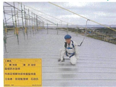
防水完了検査
