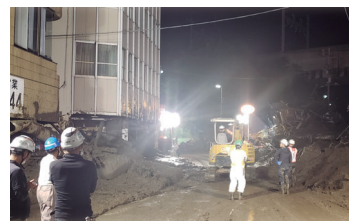
熱海土石流災害での活動の様子
