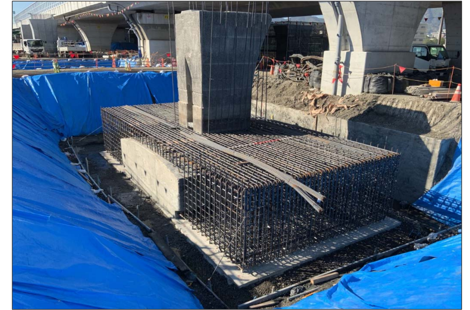
3： 底版鉄筋工
