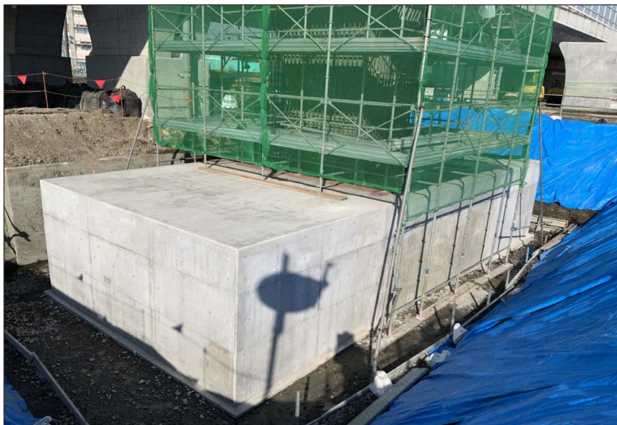
4： 底版躯体完成時
