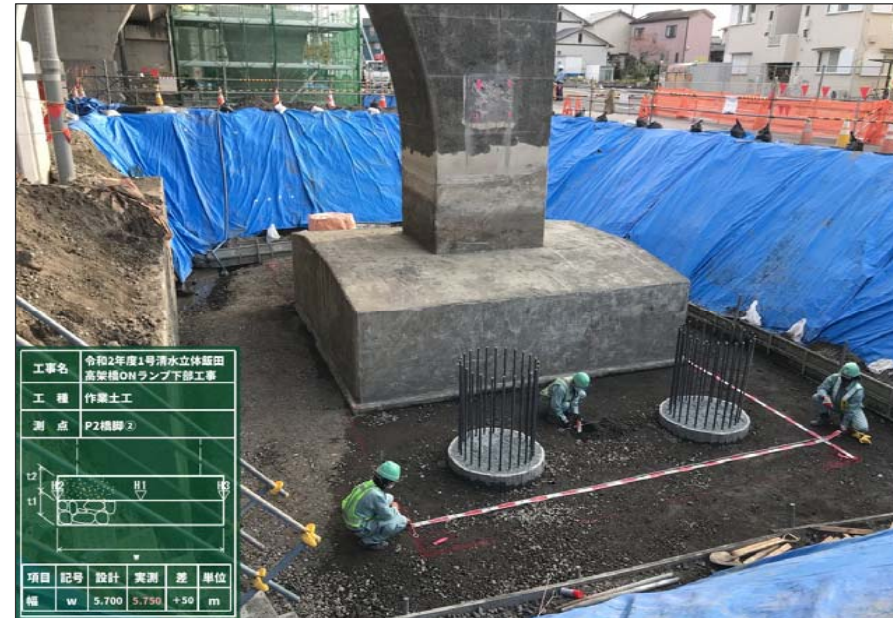
2： 場所打ち杭 杭頭処理・床掘り 完了
