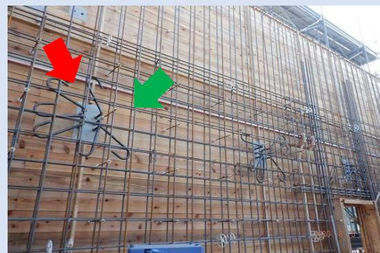
鉄骨梁アンカーボルトの精度を確保する為、躯体打込みに先立ち型枠に墨出の上、**テンプレート**を設置しました。また、躯体配筋との配筋納まりを考慮した上、**アンカーボルト**をあらかじめ加工し、現場での設置精度を高めました。
