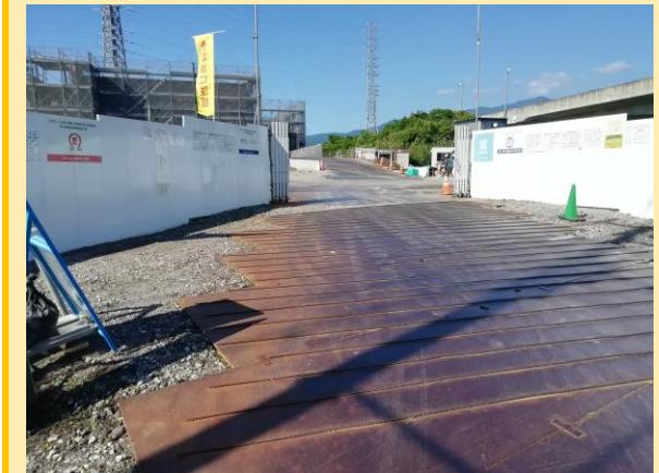
入場口に搬入車両の車高を確認できる目印を設置し、場内の架空線に対する対策を行った
