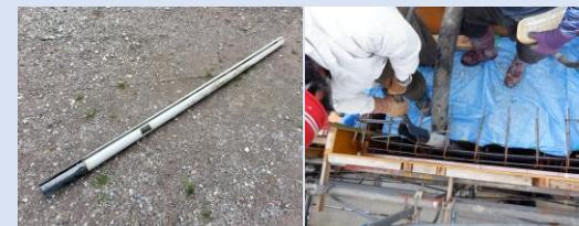
コンクリートシューターを經由してコンクリートを打設することで、骨材のみが先に落下することを防ぐことができ、壁の足元のじゃんかの発生のリスクを低減でき、躯体品質を確保することができる。
