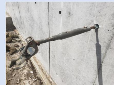
Pコンと同様の箇所に、型枠のセパを利用して専用の金物を設置することで、補修の必要がなく、壁面を美しく仕上げました
