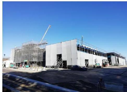
高低差のある複数の陸屋根の防水工事及び、押えコンクリート工事の前に、外部足場を使用する外壁の仕上げ工事を完了させることが、外装工程の重要管理ポイントになりました
