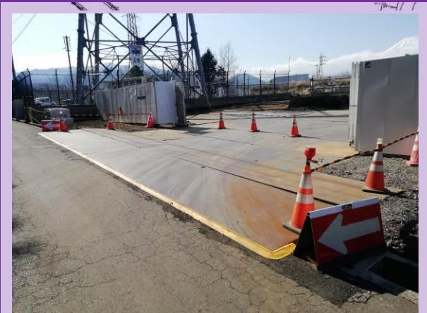
搬入口の敷き鉄板を敷いた際に生じる段差を養生し、転倒防止対策をした
