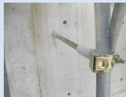
一般的には写真の様に、Pコンと別の位置に壁つなぎが設けられ、壁面に補修跡が残ってしまう。
