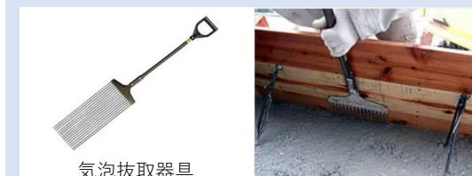
コンクリート表面の気泡採取器具を使用し、竹による締固めも併用しました。それにより、パイプレーターのみでの締固めに比べて、より密実なコンクリートが打設でき、外壁仕上げの美観の確保につながりました。
