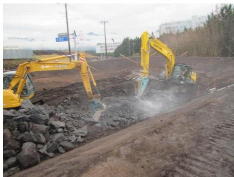
建物着工前の外構造成工事は予定外の溶岩の掘削工事が発生しましたが、発注者と協議しながら予定工程を達成しました
