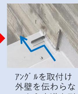
アンクルを取付け外壁を伝わないよう水道を形成し汚れを防止しました
