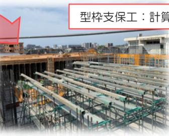
型枠支保工：計算、組立図に基づき設置
