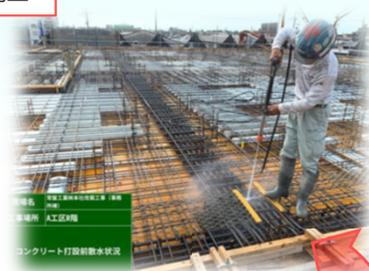
打設前の型枠散水
