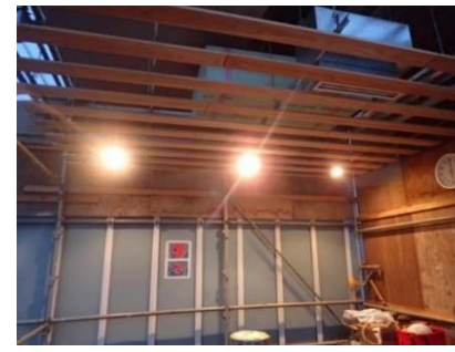
モックアップ照明設置
