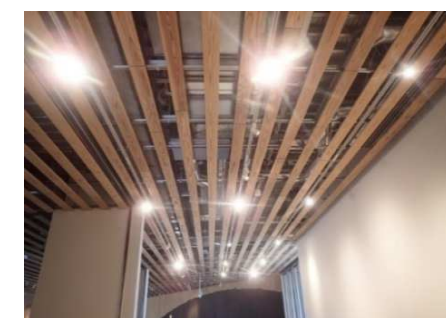
天井ルーバー 施工完了
