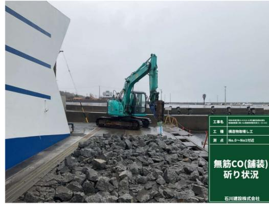
③現場打ち側溝(海側・横断) 撤去状況
