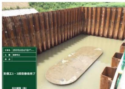
(14)仮締切工鋼矢板引抜状況
