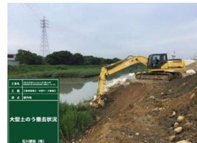
(17)工事中用道路工大型土のう設置状況
