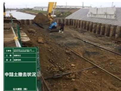
(5) 仮締切工タイロッド撤去状況
