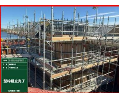
(22)橋脚躯体工梁部型枠支保工組立完了
