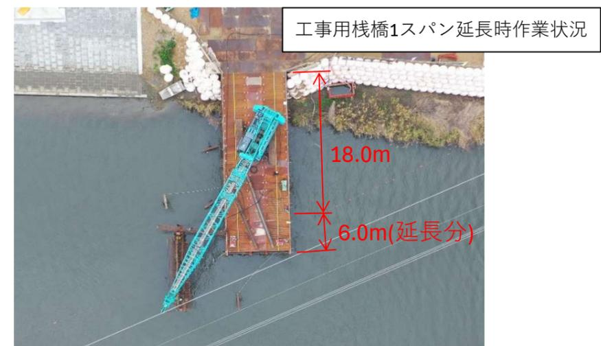
**④仮栈橋の幅がW=6.0mだと25t・50tラフテレーンクレーンのアウトリガーを最大張り出しできない。また安全通路が確保できない**
