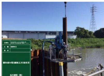
(15)工事中用棧橋工撤去状況
