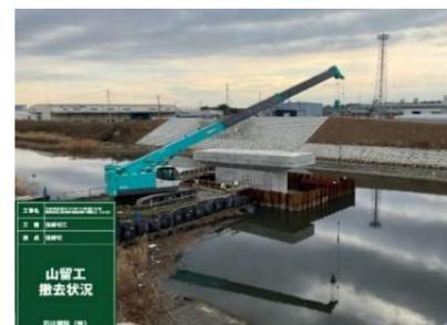
(23)仮締切工鋼矢板引抜状況
