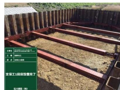
(5) 仮締切工支保工2段目設置状況
