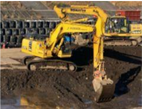
ICT建機の施工履歴データによる点群取得
