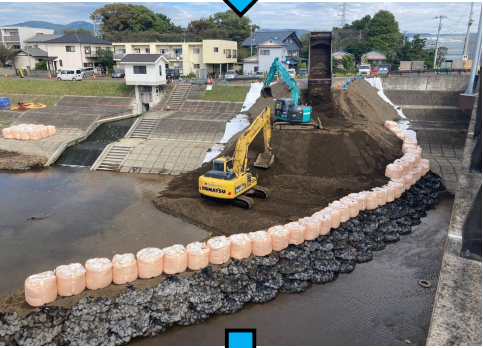
構造物撤去工
