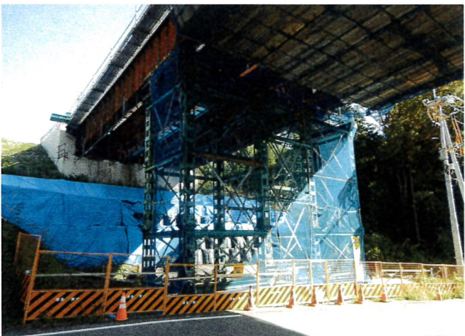
資材等が一般道へ飛来落下防止ネット設置状況
