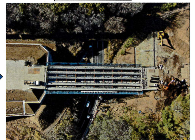
桁架設完成
