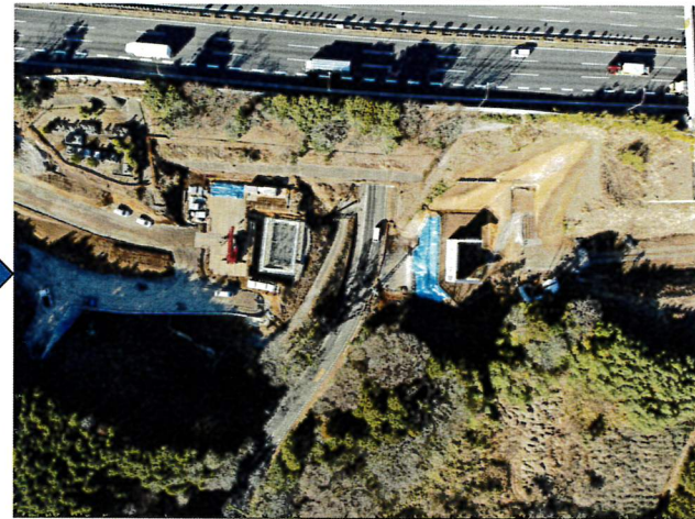
A2橋台完成
