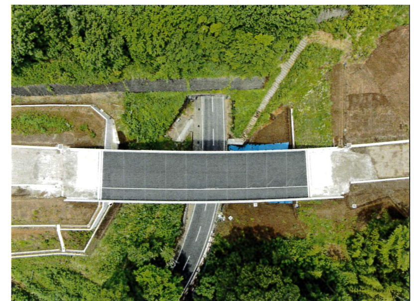
橋面舗装完成
