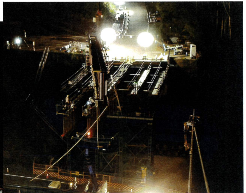
A2橋台側バルーン設置状況
