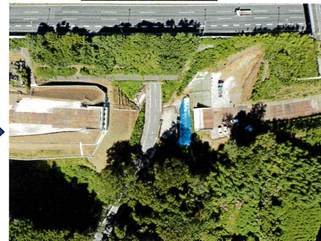
A1橋台完成
