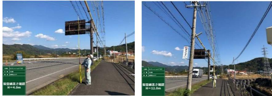
写真8 施工箇所上空の架空線通線状況
