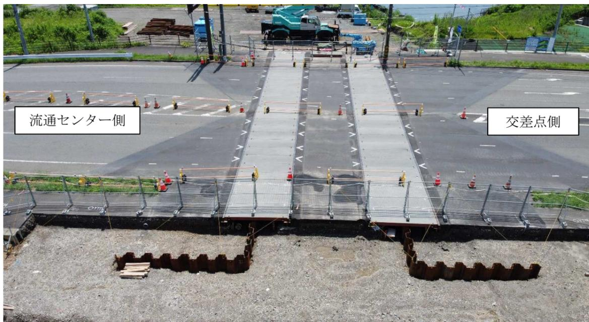
写真6 覆工板設置完了
