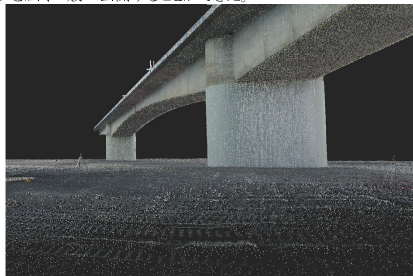
3次元データ(P2～P3橋脚を望む)
