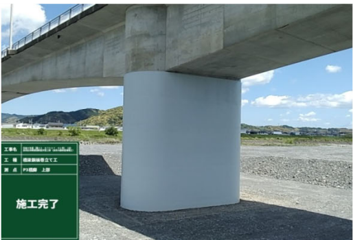
鋼板巻立て完了
