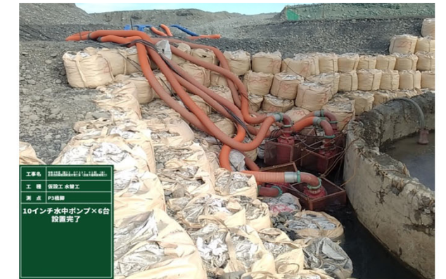
ポンプ排水状況
