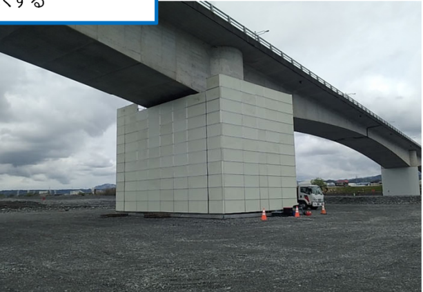
橋脚上部 足場設置完了
