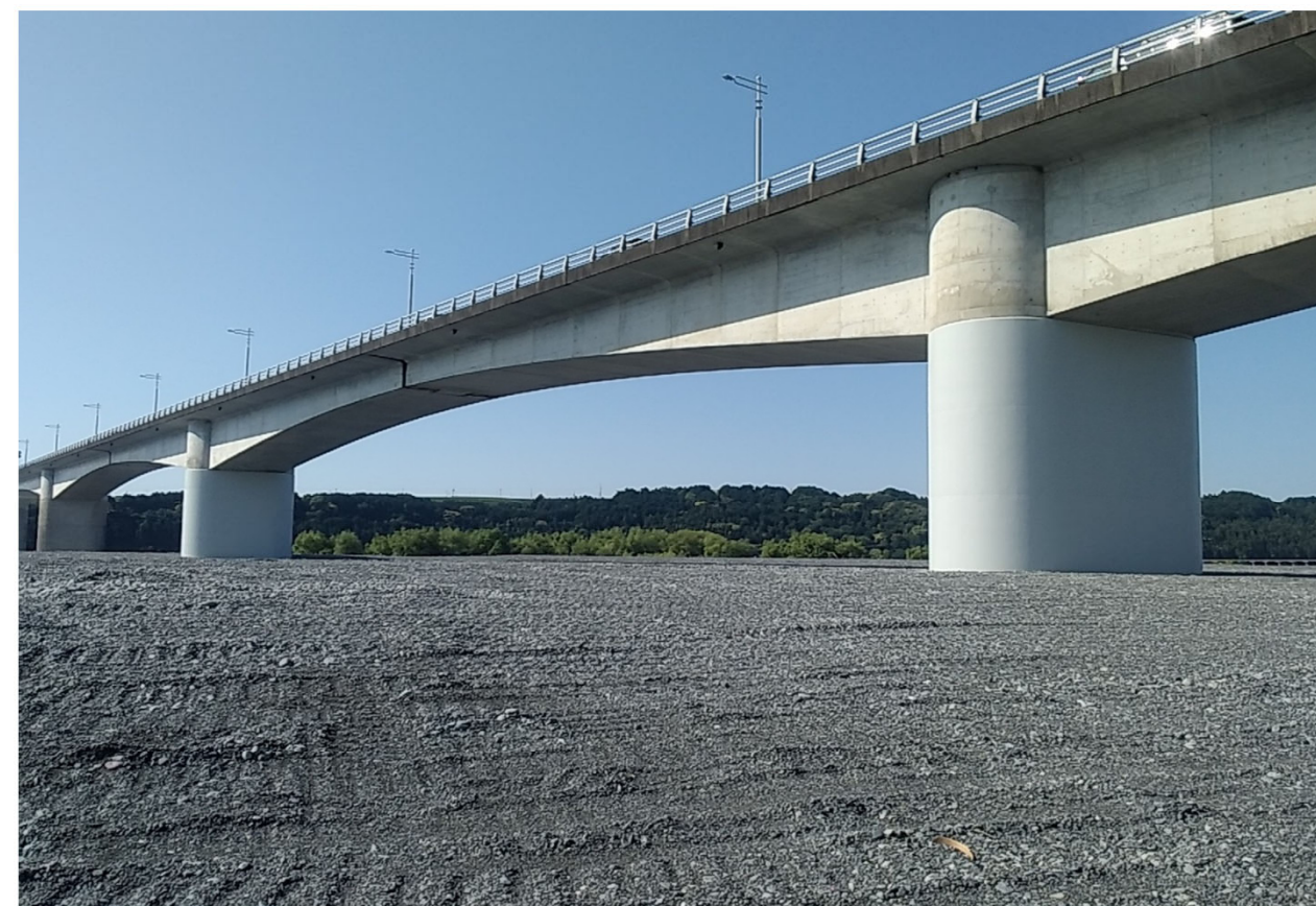
完成(P2～P3橋脚を望む)
