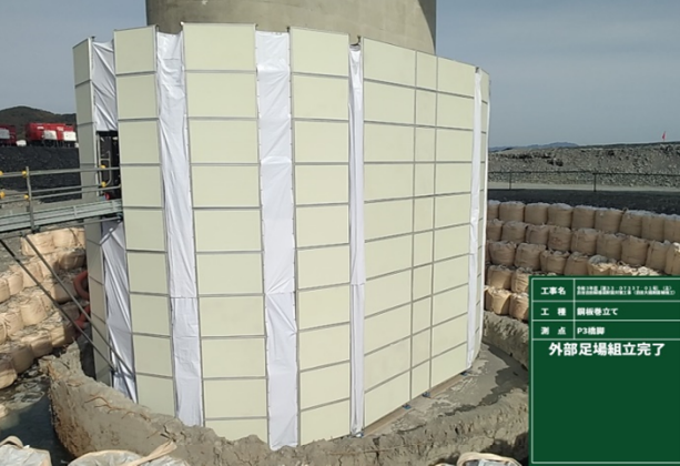
橋脚下部 足場設置完了
