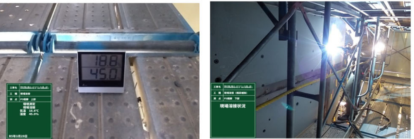
溶接時環境測定
