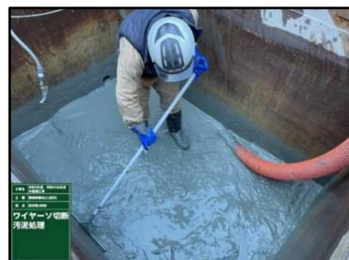
【レイタンス処理時に発生する強アルカリ水の流出防止対策】
