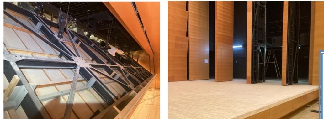
舞台機構により複雑に可動する可動天井反射板（左）と、可動側方反射板（右）
