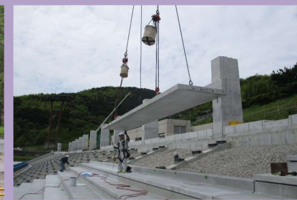
PC板据付状況
