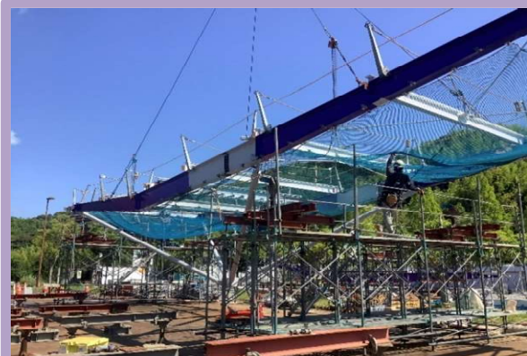
鉄骨地組状況
