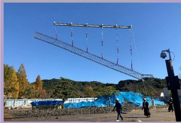
基礎配筋地組状況
