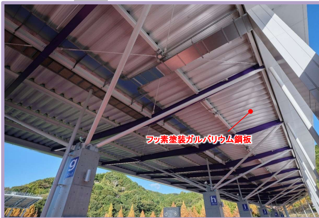
屋根・鉄骨設置
