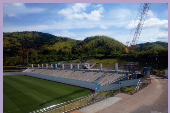
PC板据付前
