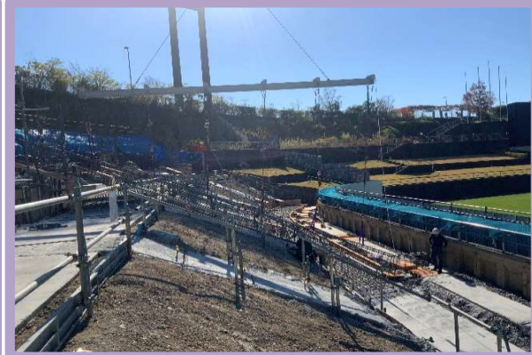
基礎配筋組立状況
