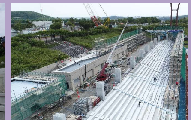
PC板据付完了
