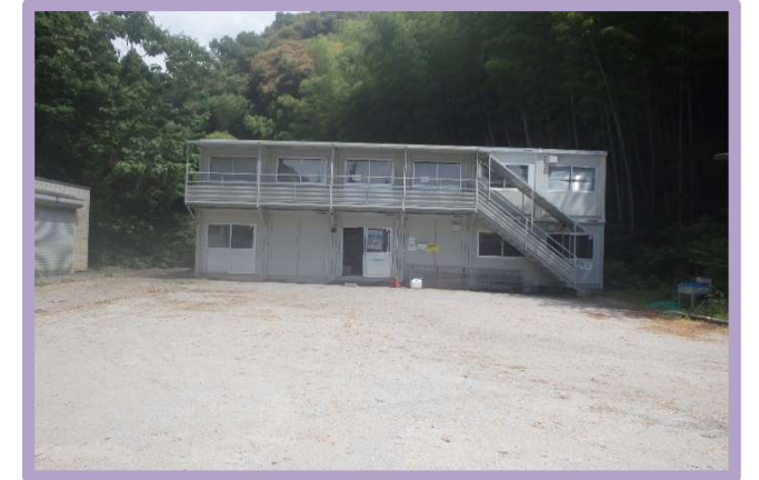
現場事務所・監理者事務所
