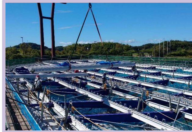
屋根工葺き施工中
