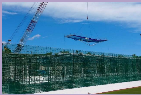
鉄骨建方状況
