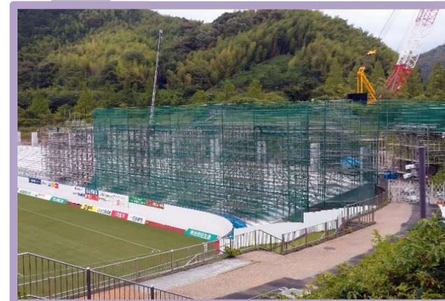
飛散防止養生ネット張り
