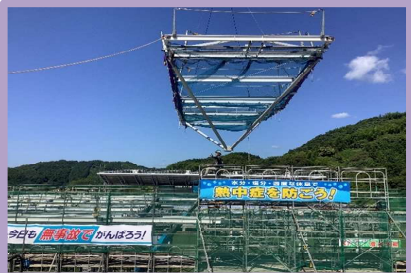
鉄骨建方状況
