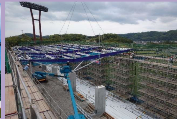
鉄骨建方状況
