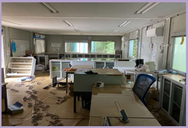
現場事務所内部状況
