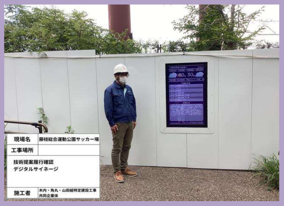
デジタルサイネージ設置
