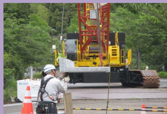
PC板吊上げ状況
