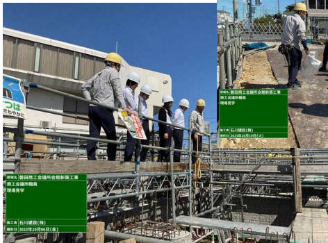
▲ 基礎工事 職員現場見学会(10/6、10)
