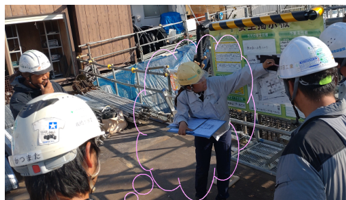
▲ コンクリート打設前作業打合せ
