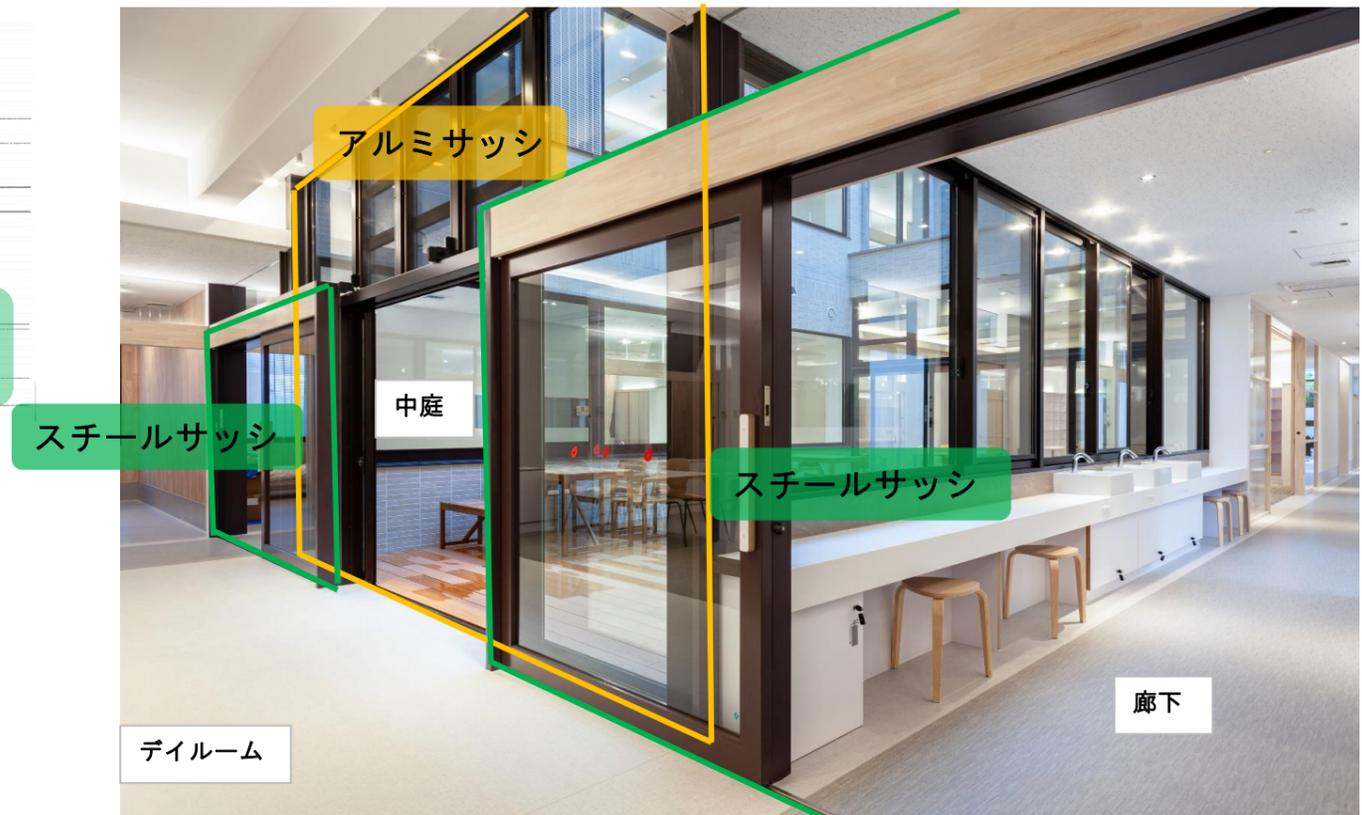
管理部門から室内全域を見渡せるようにするため、東西のコア部分以外は壁の無い計画でした。デイルームと廊下を仕切る男女分のスチールサッシは、引込部を中庭のアルミサッシと干渉させ支持させる必要がありました。アルミサッシの形状は中央引分外動で両袖はFIXとし、FIX部分にスチールサッシを引込みとすることから検討を始め、スチールサッシの形状とH寸法・W寸法を決定後アルミサッシの仮寸法が決まりました。その後スチールサッシの支持方法とアルミサッシの補強の検討を進めました。欄間サッシは引戸や内倒しを検討していたものの使い勝手や支持部材への干渉など影響がありオーニングサッシを採用することとなりました。何度も図面を修正し寸法の微調整を行うことで、アルミサッシとスチールサッシを一体化することが出来ました。
