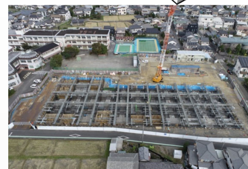
校舎 基礎工事
