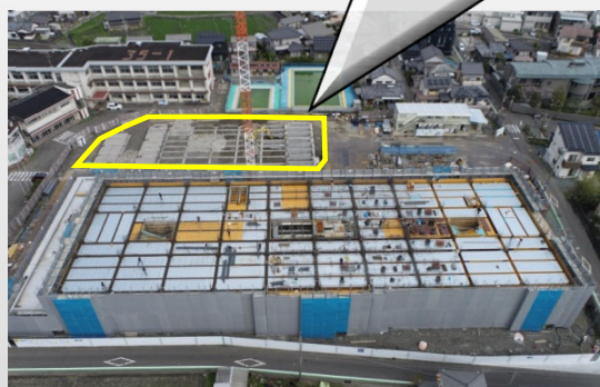
校舎 躯体工事 屋内運動場 基礎工事
