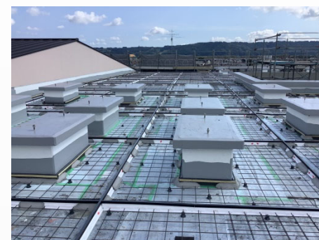
【設置状況 キャップ付目地材使用】
