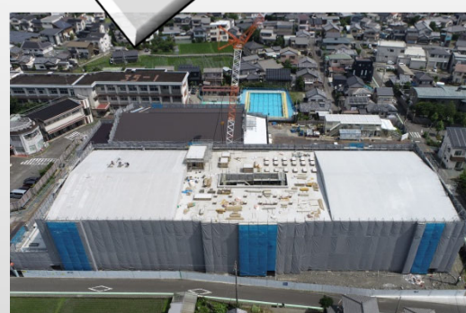
校舎 上棟（仕上工事） 屋内運動場 上棟（仕上工事）
