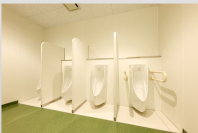
男子トイレ 隔て板の設置
