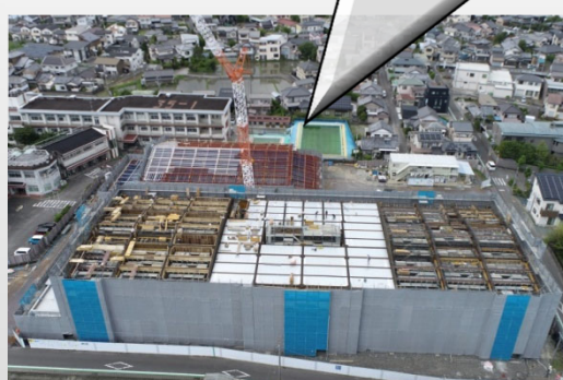
校舎 躯体工事 屋内運動場 鉄骨工事
