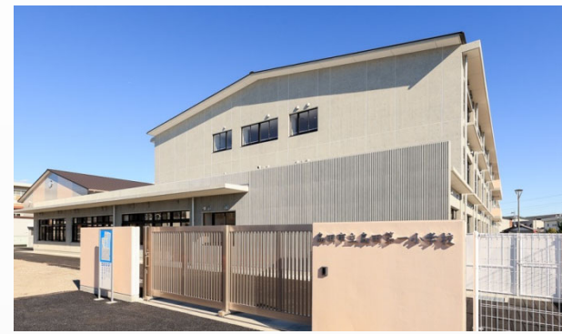
打放コンクリート完成写真
