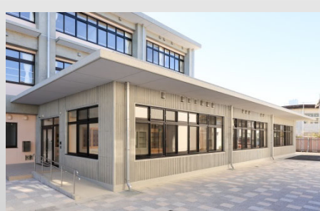
化粧コンクリート完成写真
