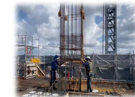
柱ユニット設置状況
