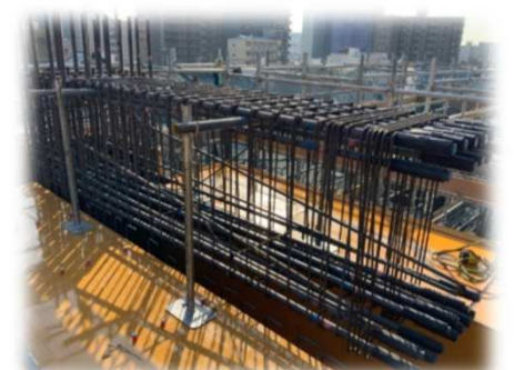
梁ユニット設置状況
