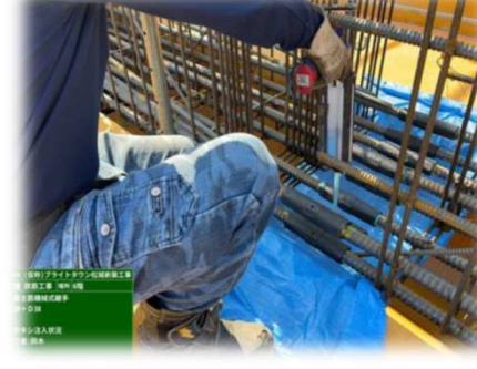
エポキシ注入
