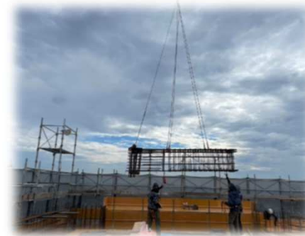
梁ユニット設置状況
