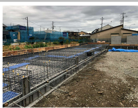
▲ユニット鉄筋配筋完了状況
