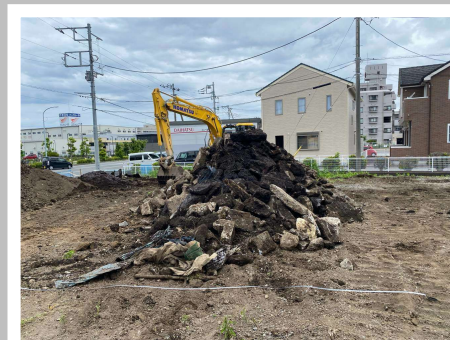
▲ 地中埋設物撤去状況
