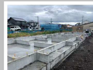
▲打設完了状況
