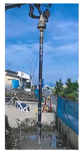
◀ 地盤改良工事施工状況
