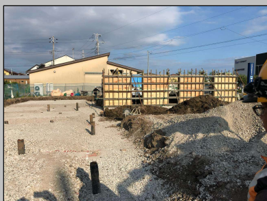
▲目隠し塀施工状況
