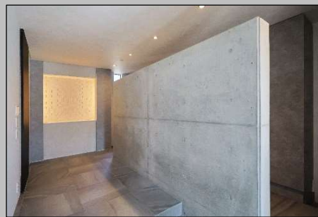
▲ 屋内外を繋ぐ床タイルと目隠し壁、エコカラット、全てが調和された玄関
