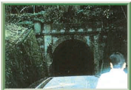
▲明治のトンネル
