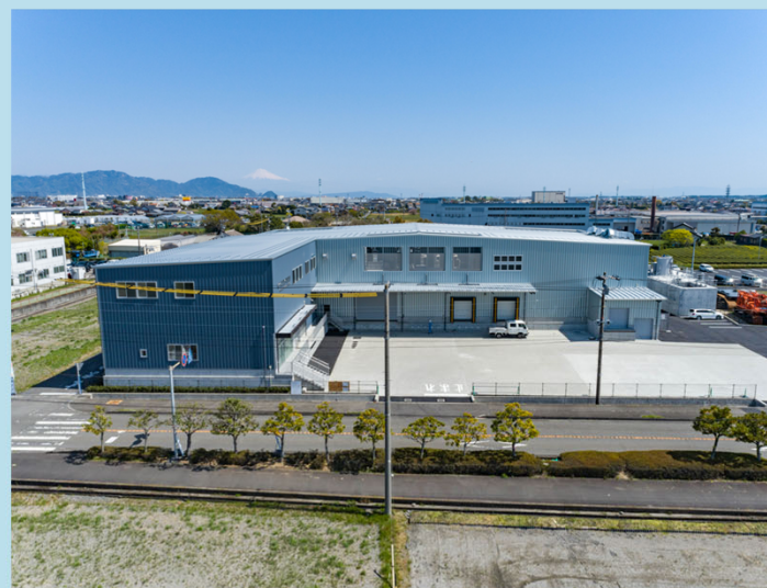
【西面外観写真】
