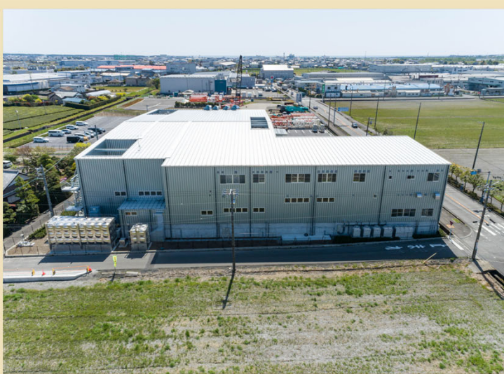
【北面外観写真】
