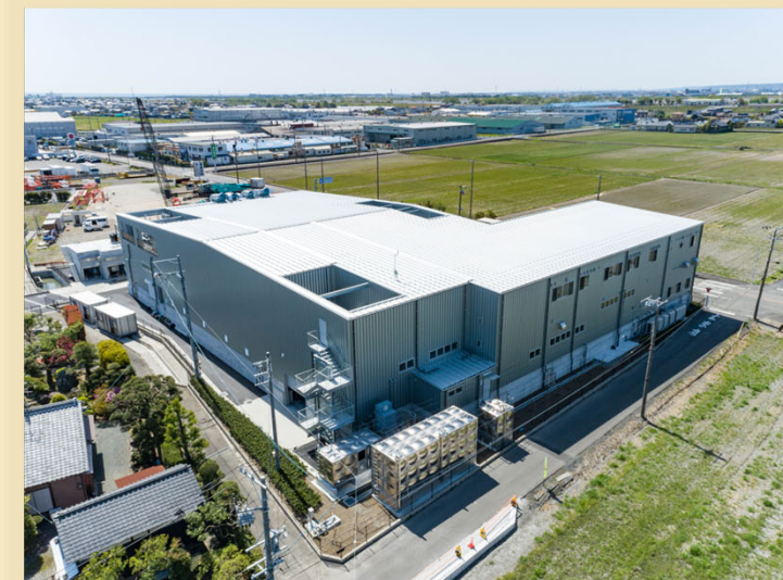
【北東面外観写真】
